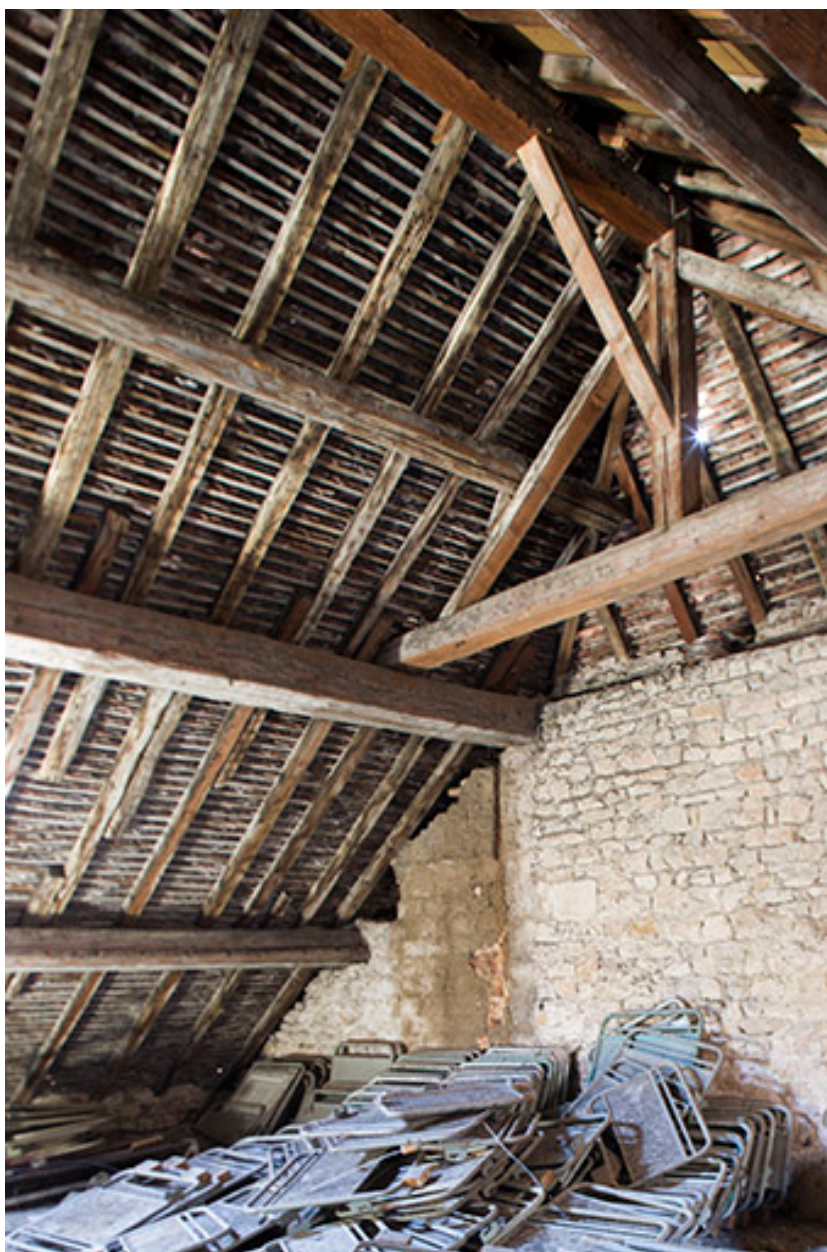
Maison Bonotte : détail de la charpente.
