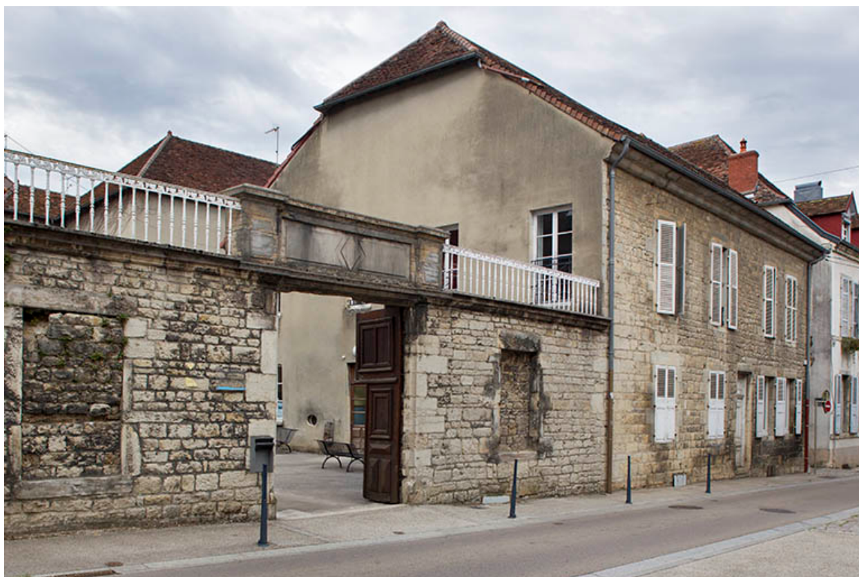
Entrée, rue du collège.
