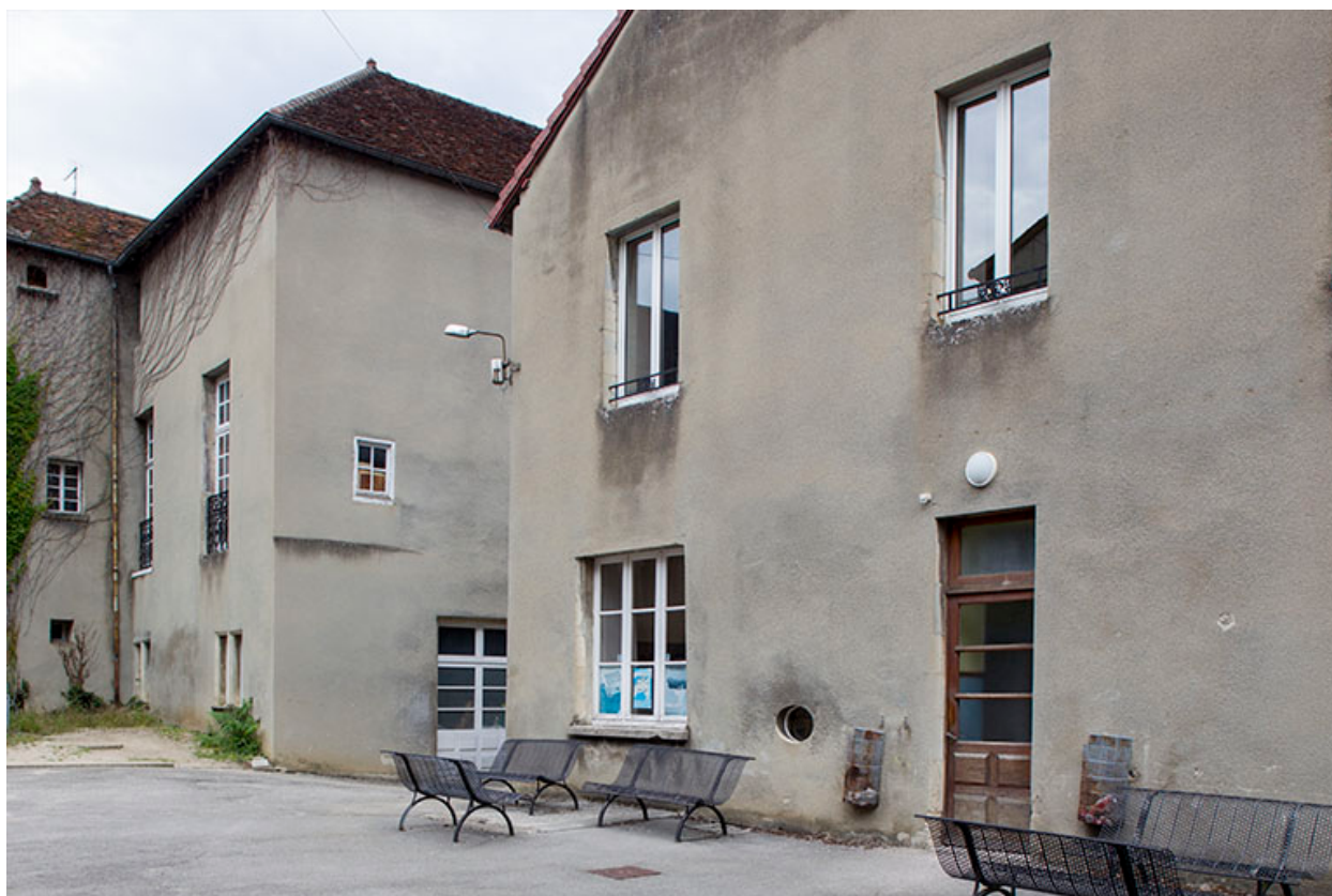
Vue des façades sur cour .
