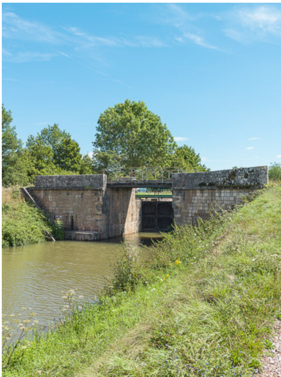
Vue d'ensemble du pont.
