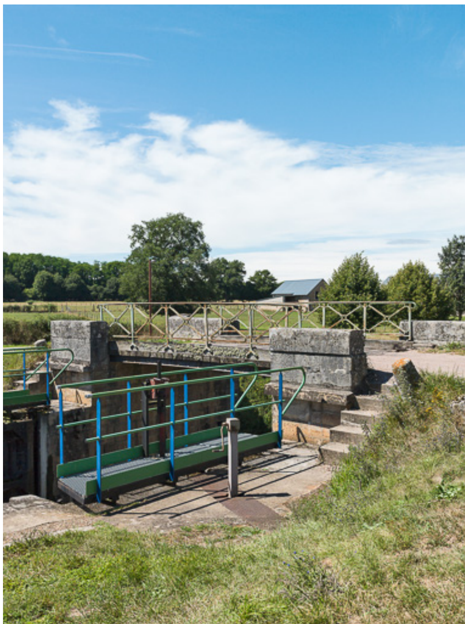
Vue rapprochée du pont et des escaliers.
