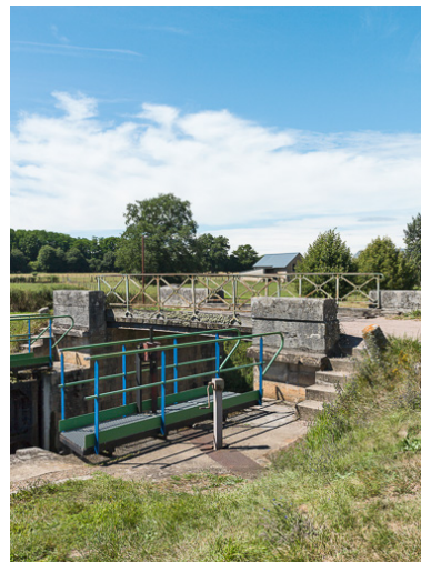
Vue rapprochée du pont et des escaliers. Phot. Pierre-Marie Barbe-Richaud IVR26_20175800349NUC2A
