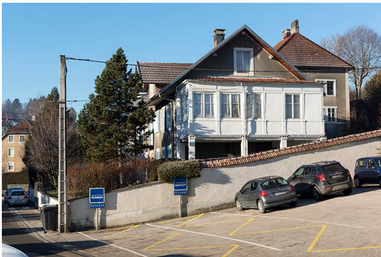
Extension : façade latérale droite.
