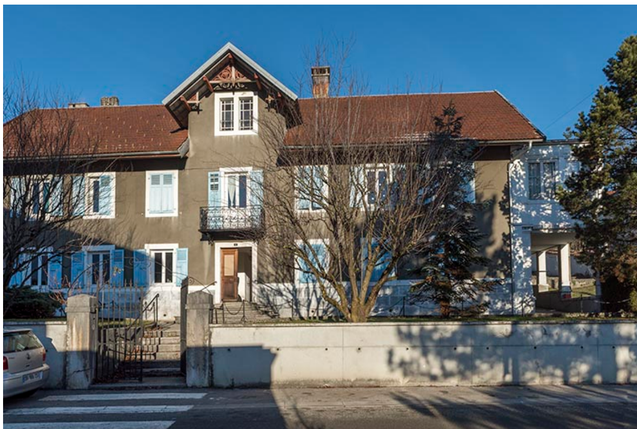
Extension : façade antérieure.
