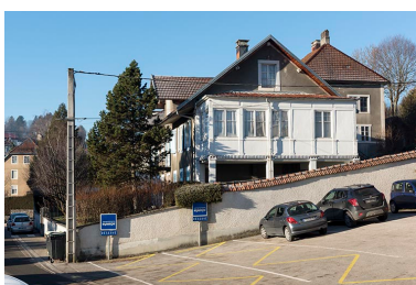
Extension : façade latérale droite. Phot. Sonia Dourlot
