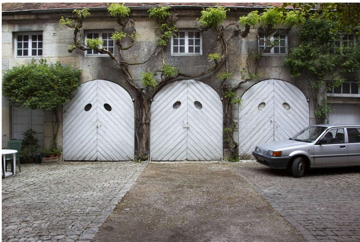
Vue des remises et écuries de face.
