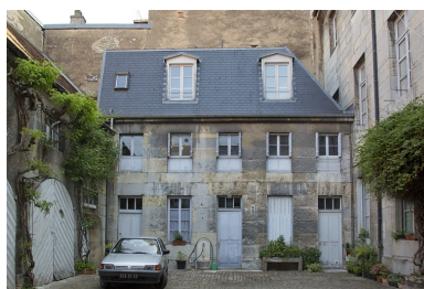
Vue de l'aile droite des communs. Phot. Yves Sancey IVR43_20112500774NUC2A
