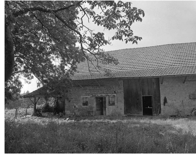
Partie agricole. Phot. Dominique Dominguez IVR43_19773900081X
