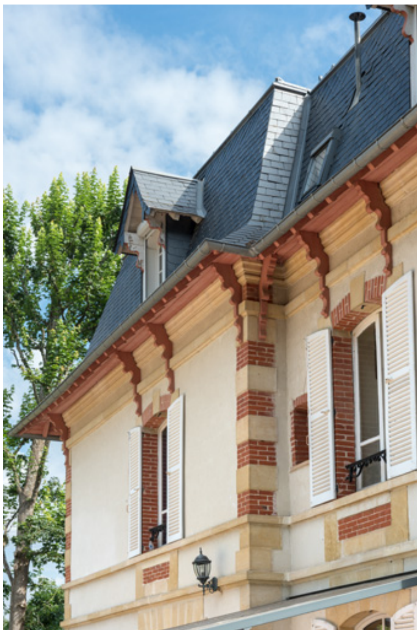
Détail de l'avant-corps de la façade postérieure, baies de l'étage carré et toiture à égout retroussé.
