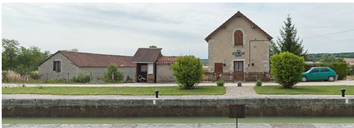
Vue d'ensemble du site d'écluse.
