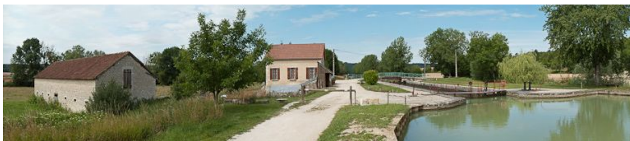
Vue d'ensemble du site d'écluse.
