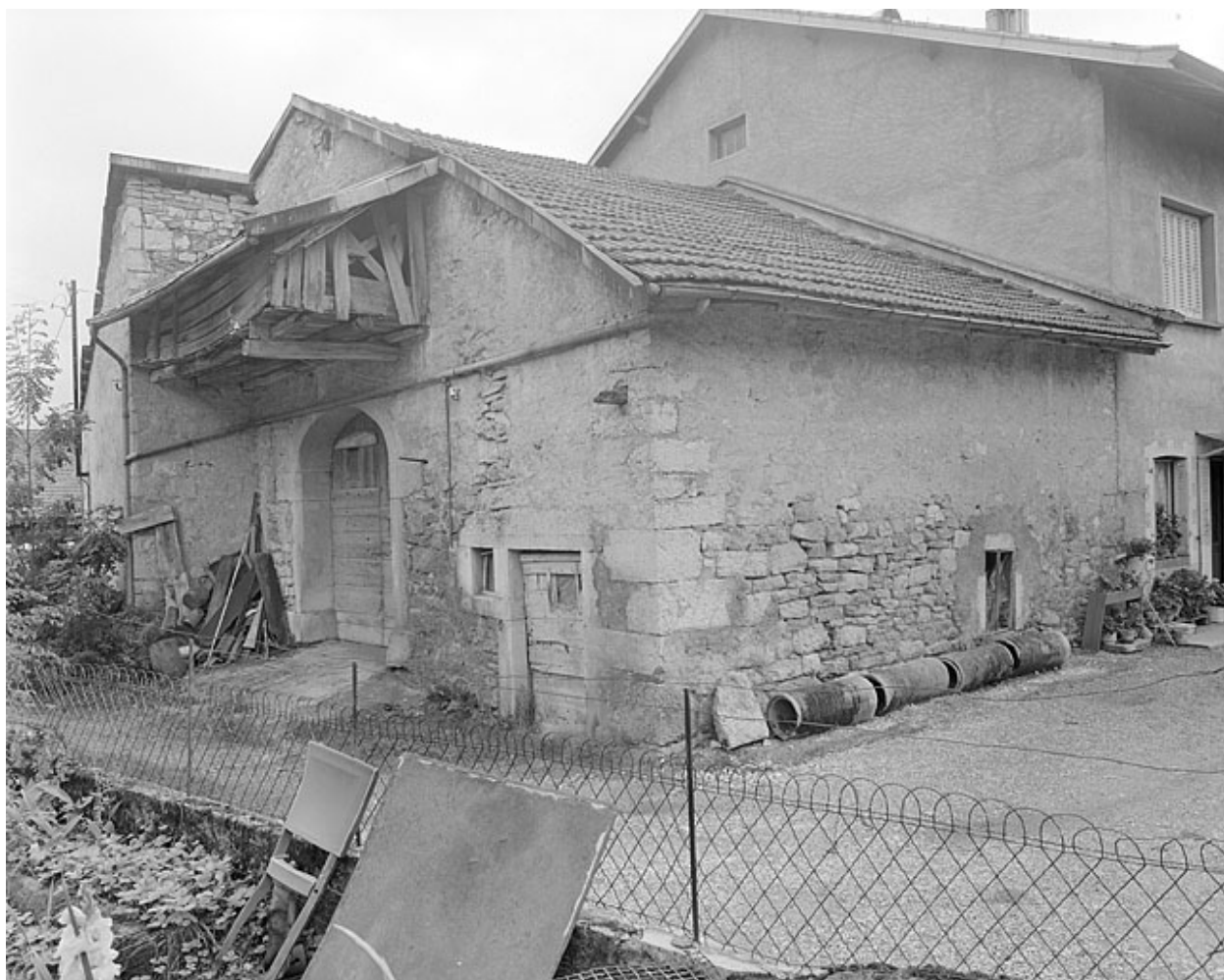
Face latérale et façade postérieure.
