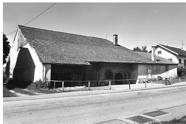
Gouttereau sur rue. Phot. Bernard Lardière IVR43_19782500308X
