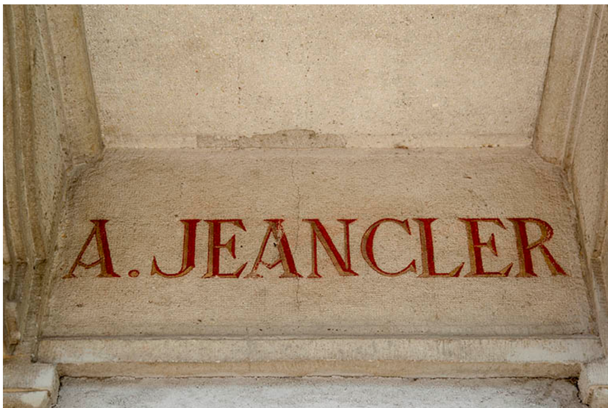
Façade antérieure : partie centrale de l'enseigne peinte.
