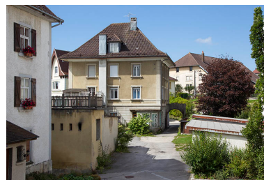
Vue d'ensemble, depuis l'est (façade postérieure). Phot. Sonia Dourlot IVR43_20152500837NUC2A
