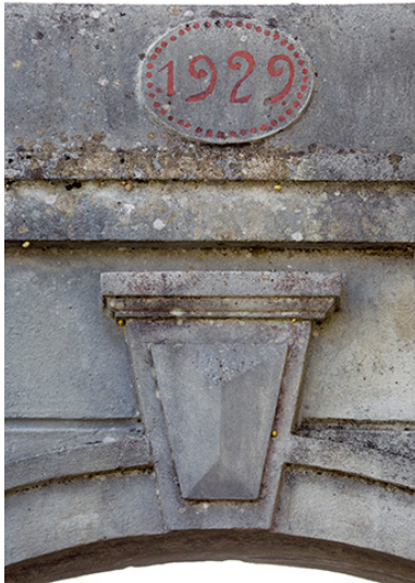
Portail : date et clé de voûte.
