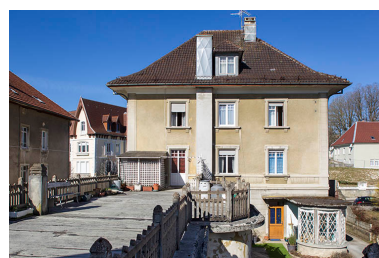
Façade postérieure et terrasse surmontant la cuisine. Phot. Sonia Dourlot IVR43_20152500839NUC2A
