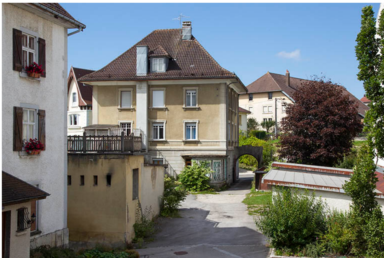
Vue d'ensemble, depuis l'est (façade postérieure).
