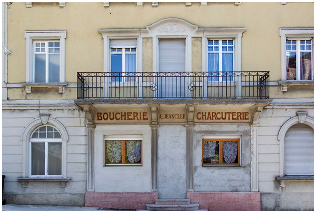
Façade antérieure : travées centrales.
