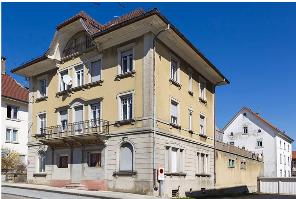
Façades antérieure et latérale droite.
