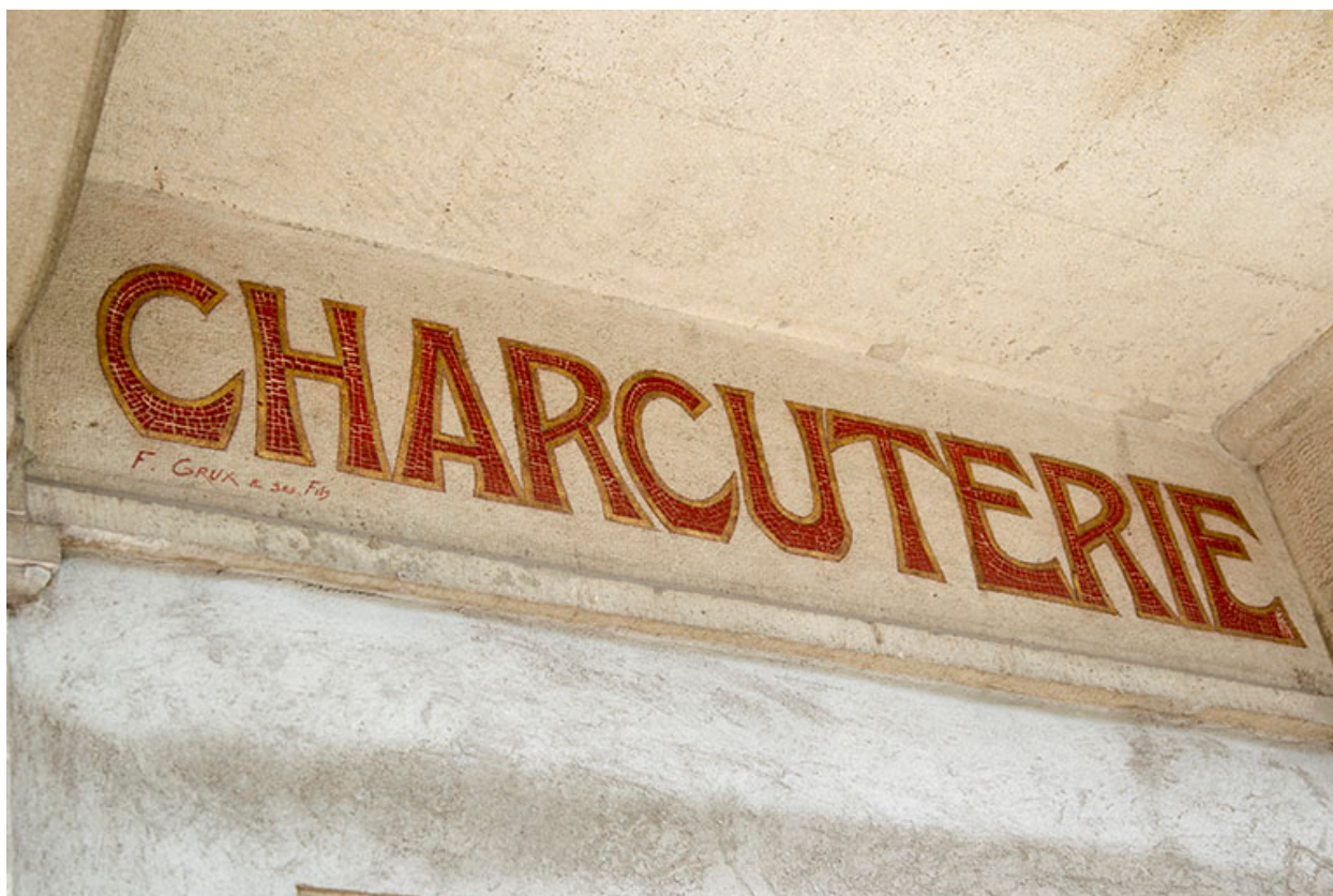
Façade antérieure : partie droite de l'enseigne peinte.
