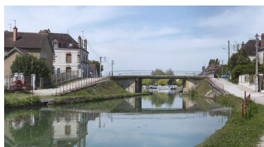
Vue d'ensemble prise d'aval.
