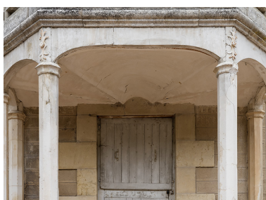
Balcon du rez-de-chaussée surélevé reposant sur une voûte en éventail armée. Phot. Pierre-Marie Barbe-Richaud IVR26_20195800640NUC4A
