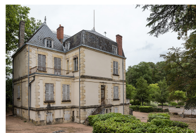
Élévation sud-ouest, vue depuis l'ouest. Phot. Pierre-Marie Barbe-Richaud IVR26_20195800631NUC4A
