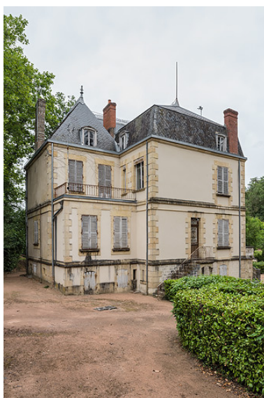
Élévation sud-ouest, vue depuis l'ouest. Phot. Pierre-Marie Barbe-Richaud IVR26_20195800630NUC4A
