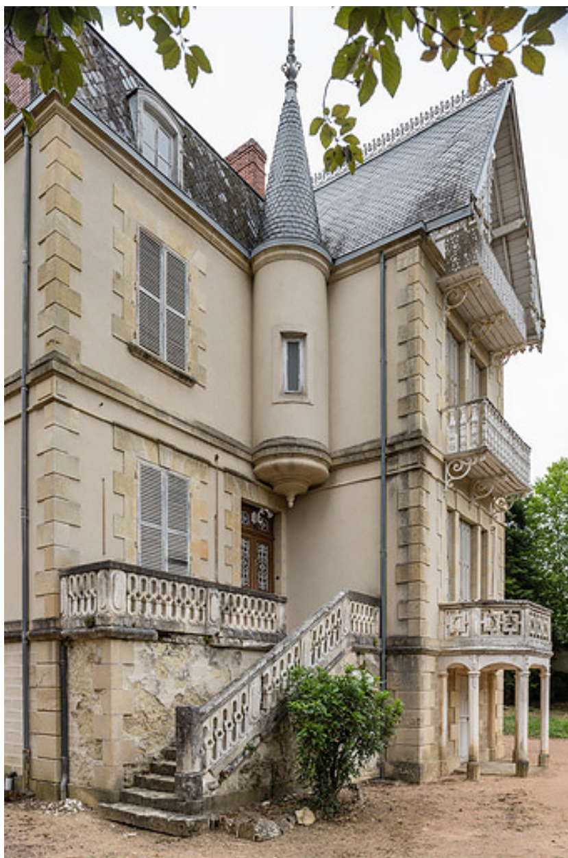
Tourelle d'angle en surplomb.
