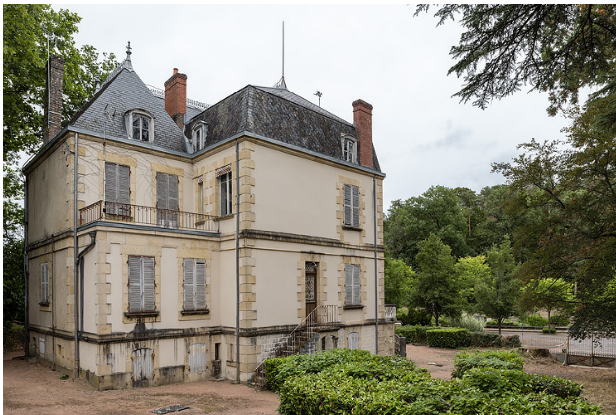
Élévation sud-ouest, vue depuis l'ouest.
