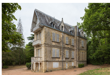
Façade sur le jardin du corps oriental. Phot. Pierre-Marie Barbe-Richaud IVR26_20195800627NUC4A
