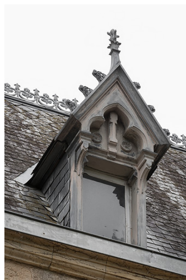
Lucarne (troisième type) du corps oriental. Phot. Pierre-Marie Barbe-Richaud IVR26_20195800639NUC4A
