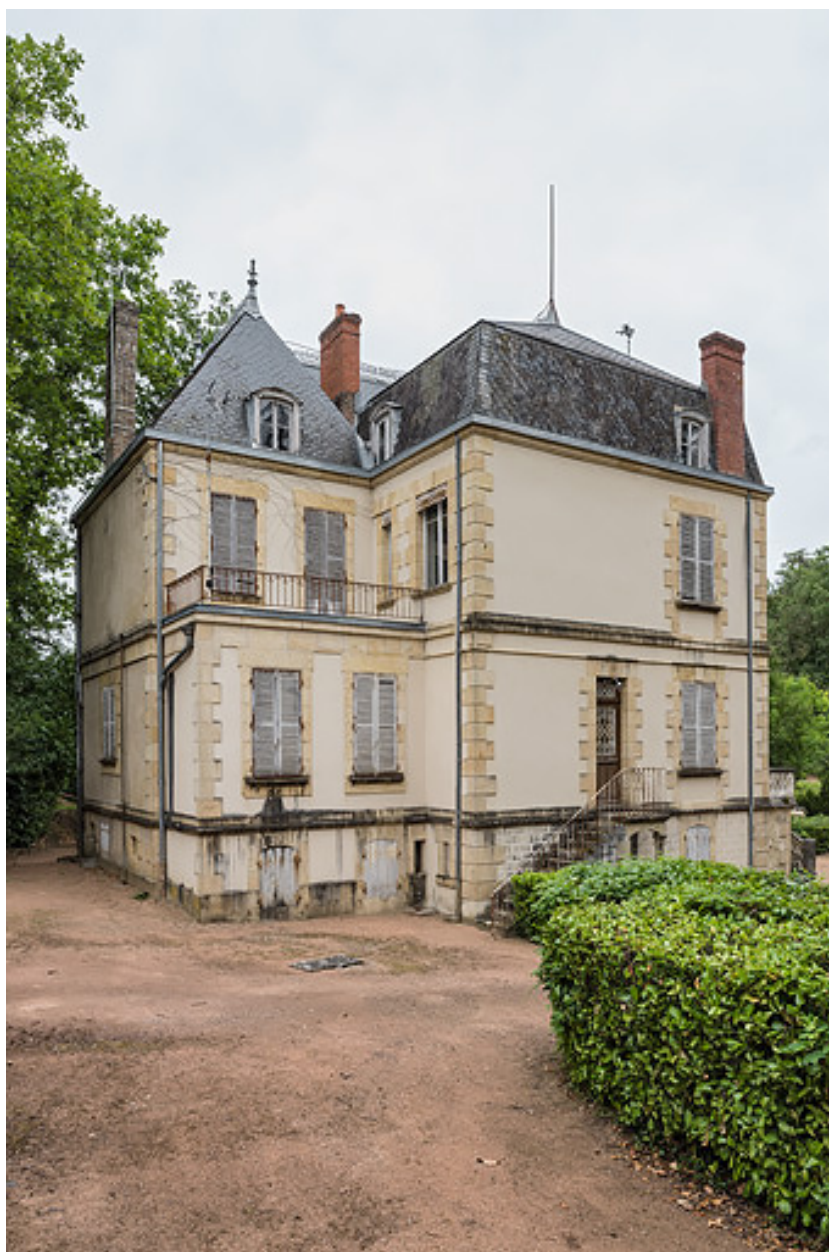
Élévation sud-ouest, vue depuis l'ouest.
