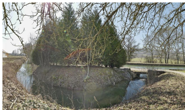
Arrivée au canal de la rigole d'alimentation. Phot. Thierry Kuntz IVR26_20122102657NUC4A
