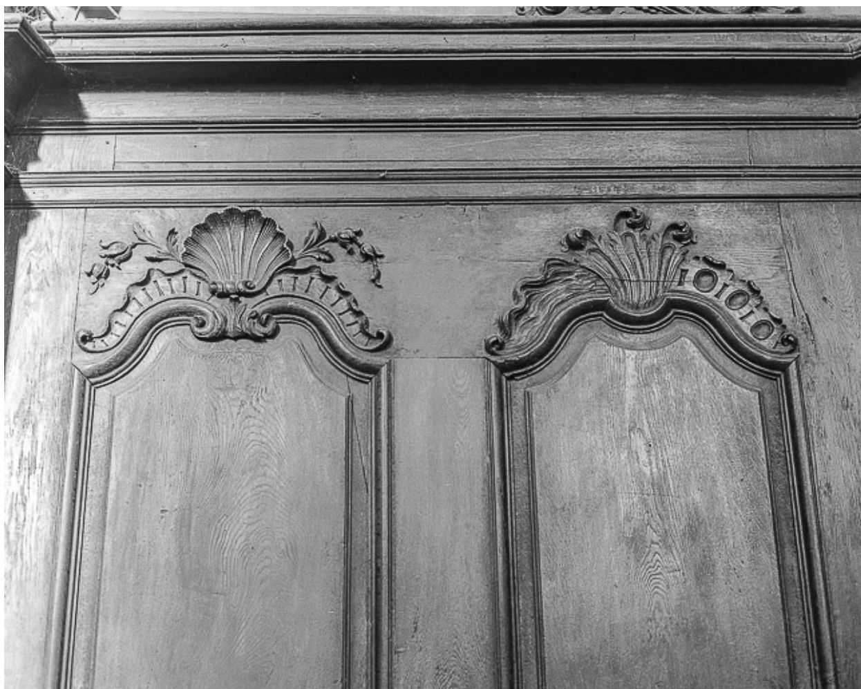
Détail de la partie supérieure des boiseries.
