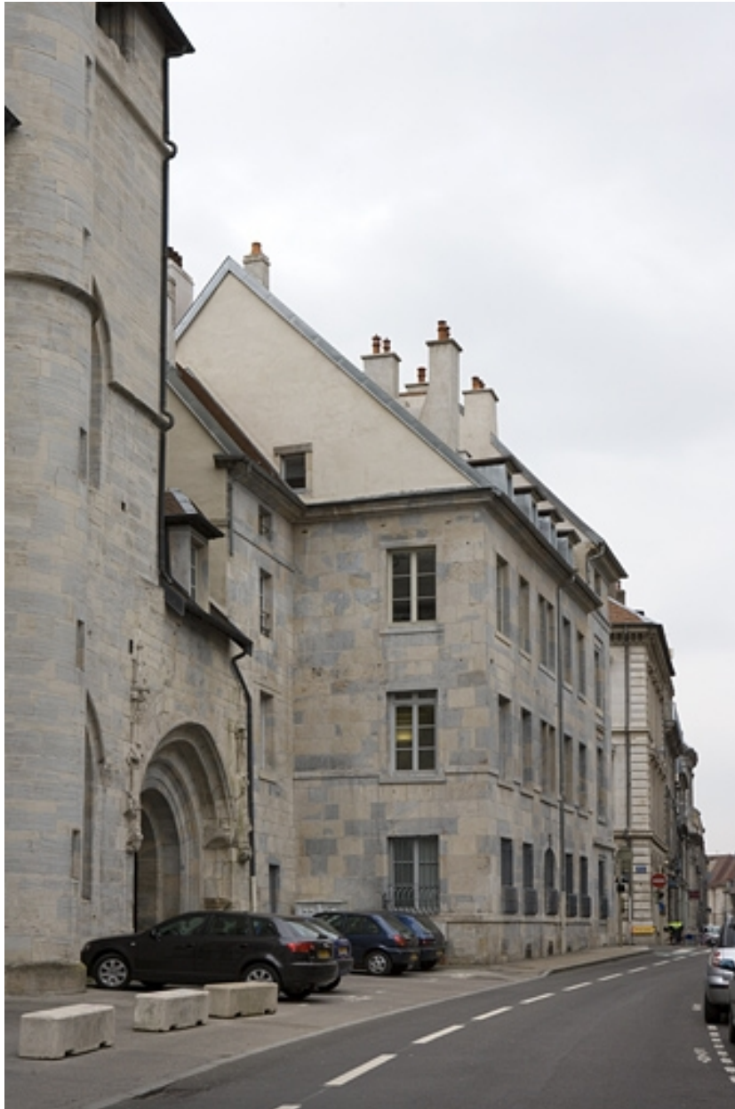
Vue d'ensemble rapprochée depuis la rue Mégevand.
