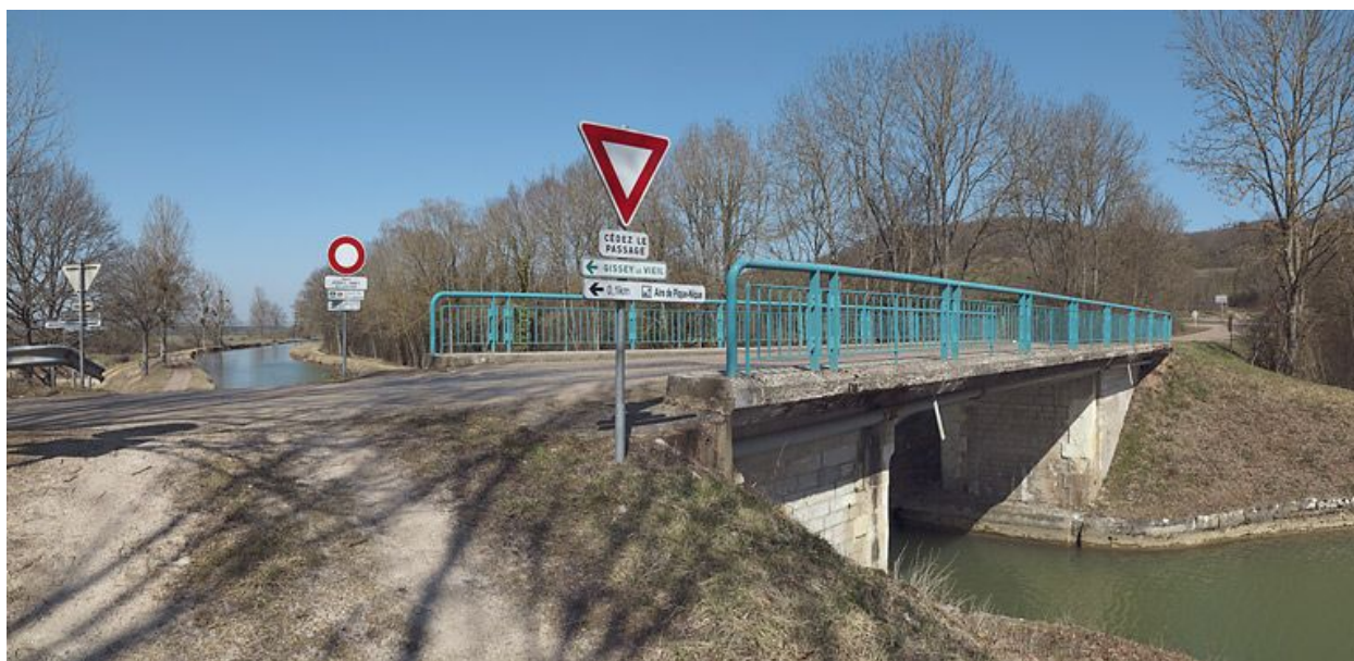
Vue d'ensemble du pont.
