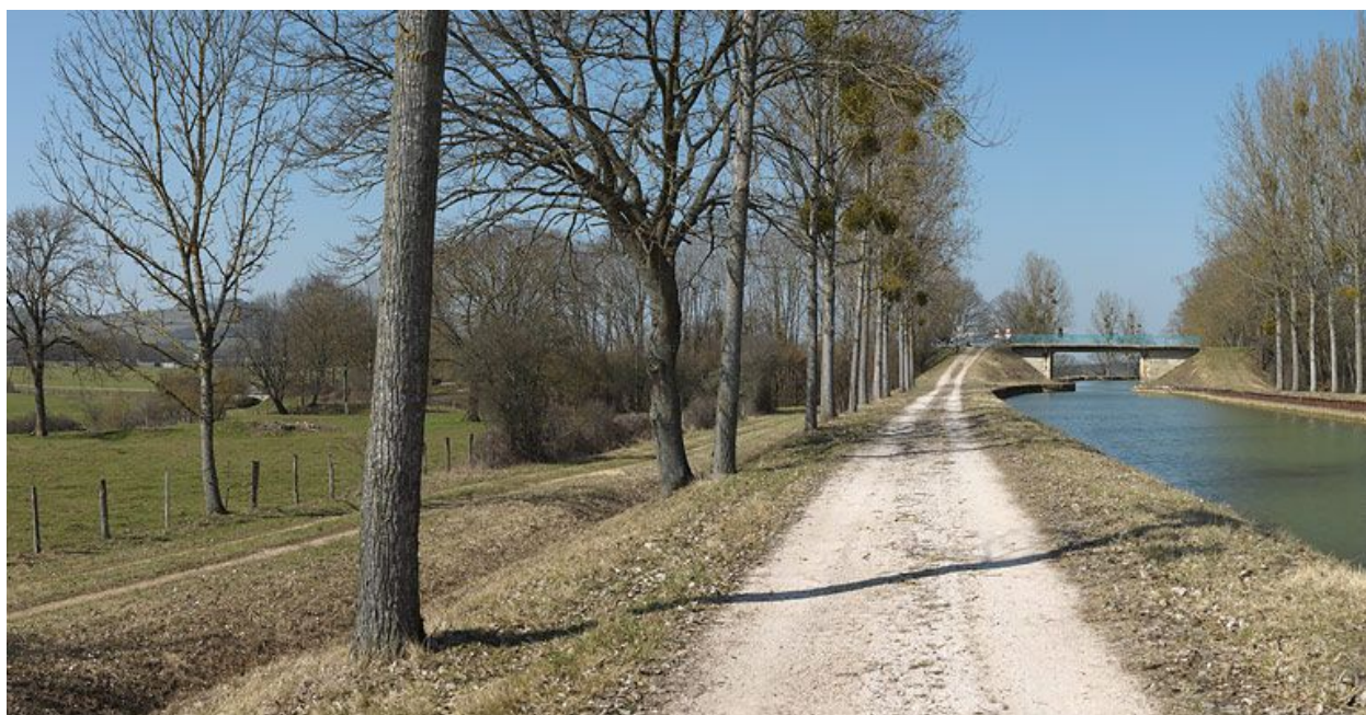
Vue d'ensemble du pont.
