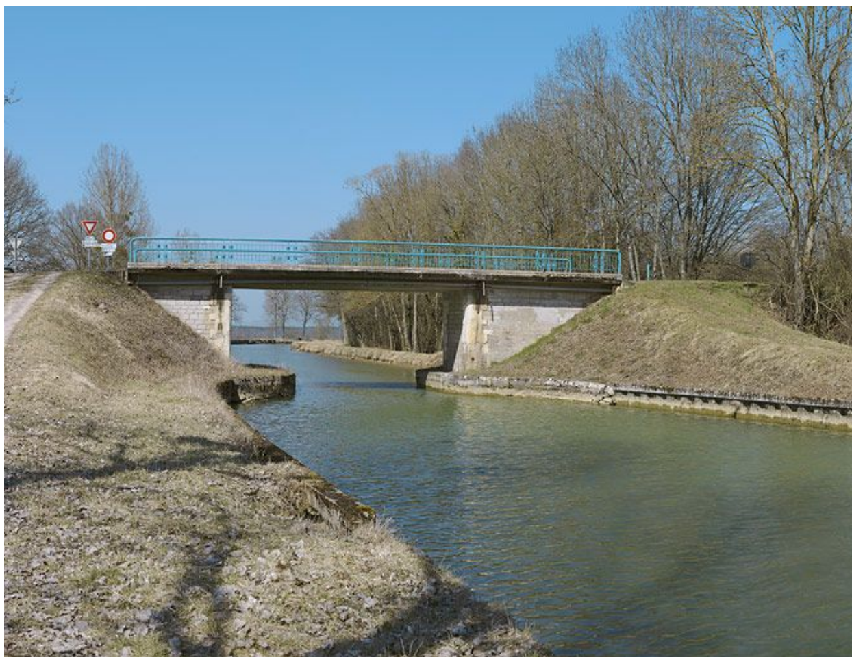
Vue d'ensemble du pont.
