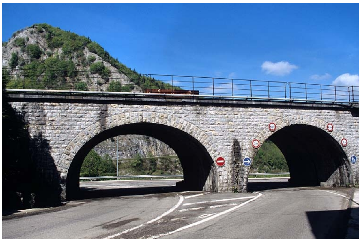
Elévation occidentale : arches enjambant la rue.
