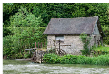
Façade est du bâtiment d'eau, et roue hydraulique pendante. Phot. Jérôme Mongreville IVR43_20162500385NUC4A
