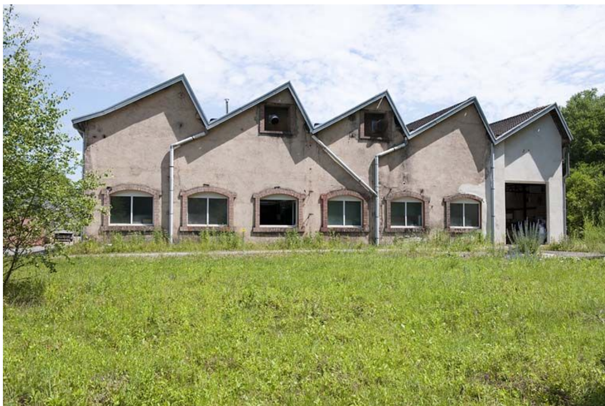
Atelier de fabrication des pompes. Mur-pignons ouest.
