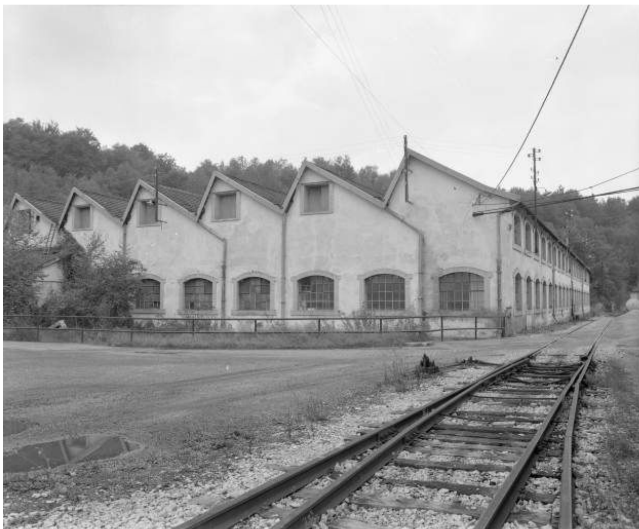
Vue rapprochée de l'atelier des pompes en 1981.
