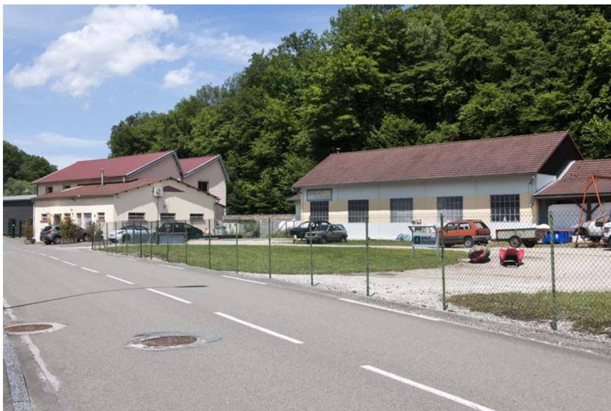
Vue rapprochée depuis le nord-ouest.
