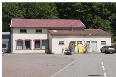
Atelier d'entretien. Phot. Jérôme Mongreville IVR43_20112501665NUC4A
