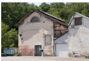
Ancienne chaufferie. Phot. Jérôme Mongreville IVR43_20112501180NUC4A
