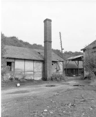
La chaufferie et sa cheminée en 1981. Phot. Yves Sancey IVR43_19812500571X
