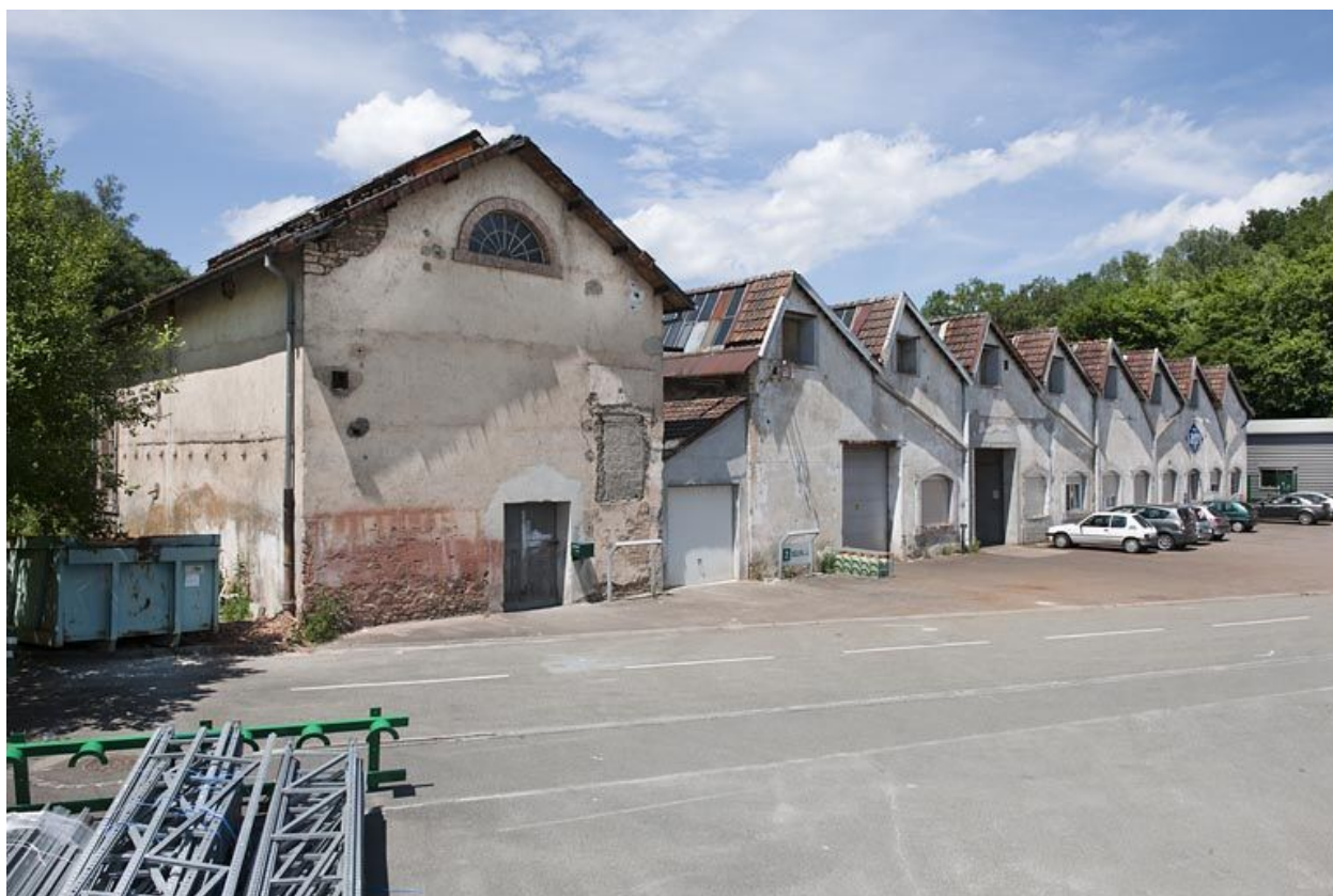
Atelier de fabrication des pompes. Mur-pignons est.
