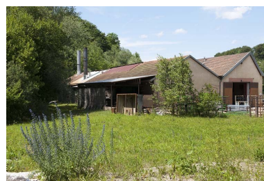
Magasin général. Vue de trois quarts arrière. Phot. Jérôme Mongreville IVR43_20112501184NUC4A
