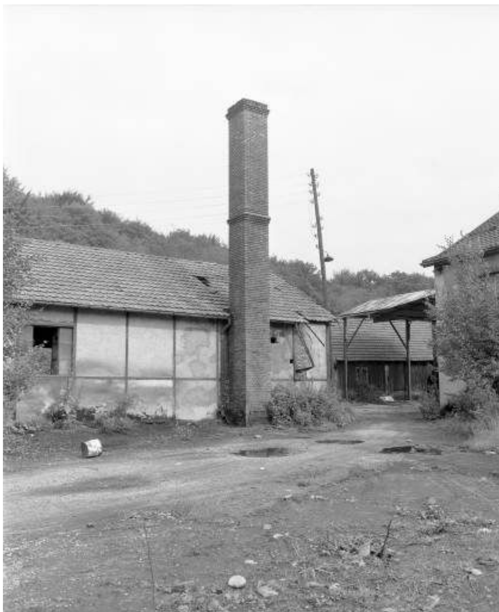
La chaufferie et sa cheminée en 1981.
