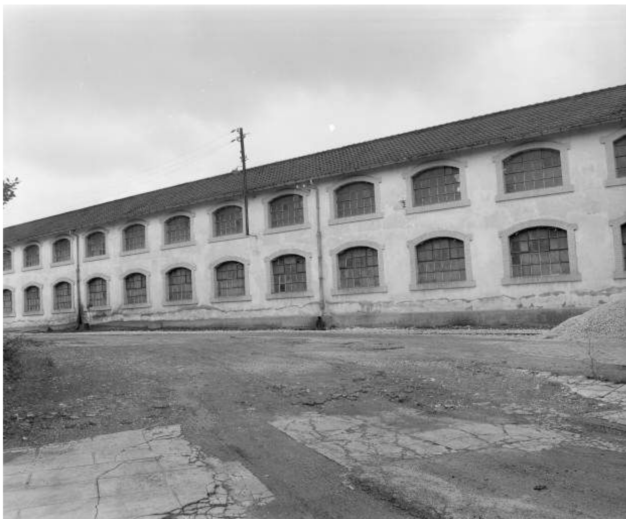
Façade nord de l'atelier des pompes en 1981.
