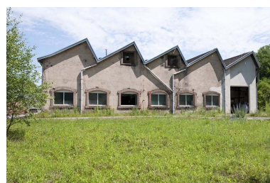
Atelier de fabrication des pompes. Mur-pignons ouest. Phot. Jérôme Mongreville IVR43_20112501185NUC4A
