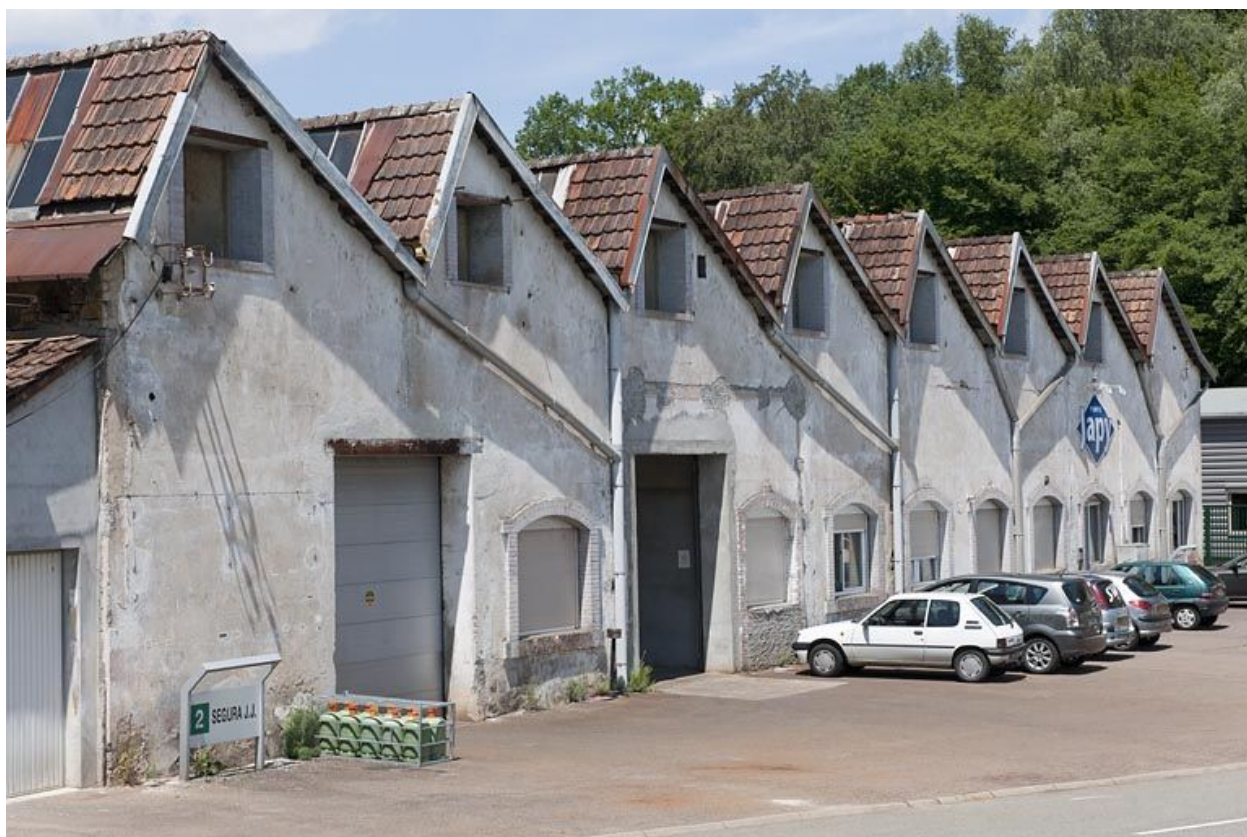
Atelier de fabrication des pompes. Sheds est.
