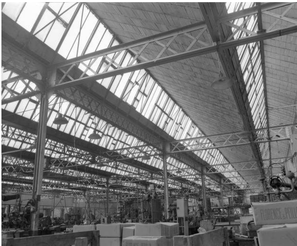
Vue intérieure de l'atelier des pompes en 1981.
