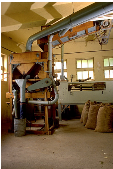
Vue d'ensemble. Phot. Jérôme Mongreville IVR43_19973900701ZA
