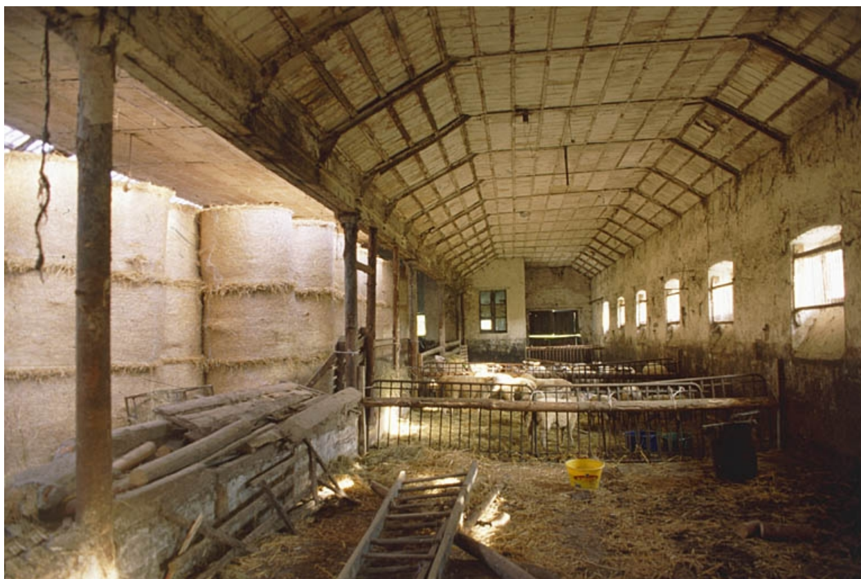
Travée sud de l'étable.
