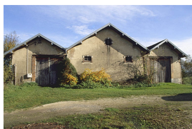
Murs-pignons du fenil. Phot. Yves Sancey IVR43_20009000731ZA
