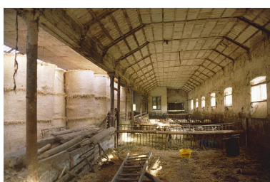
Travée sud de l'étable. Phot. Yves Sancey IVR43_20009000740ZA
