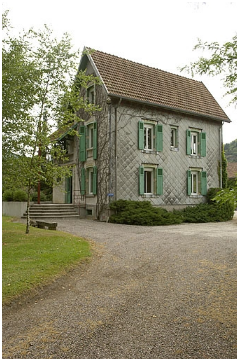
Ancien logement patronal. Vue depuis l'entrée.
