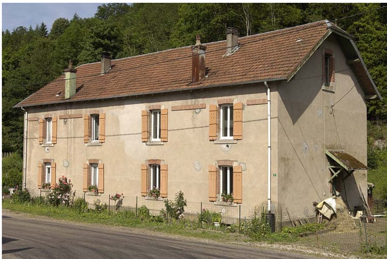
Logement ouvrier collectif.
