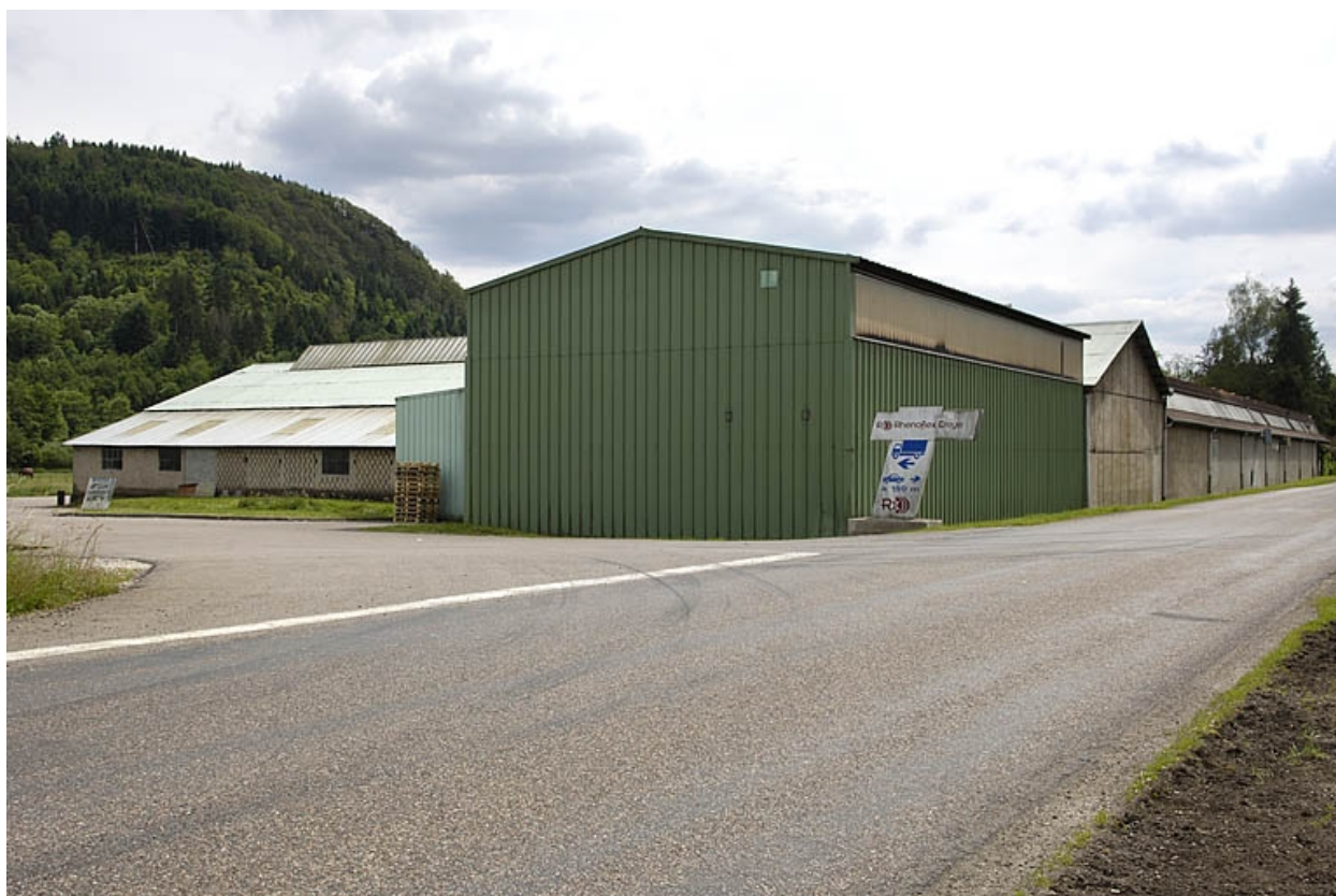
Extensions nord (entrepôts industriels).
