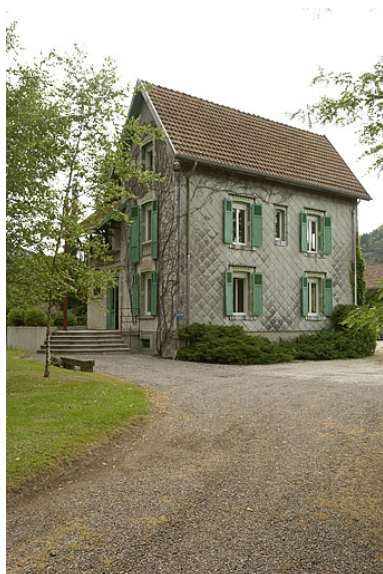
Ancien logement patronal. Vue depuis l'entrée. Phot. Jérôme Mongreville IVR43_20057000317NUCA
