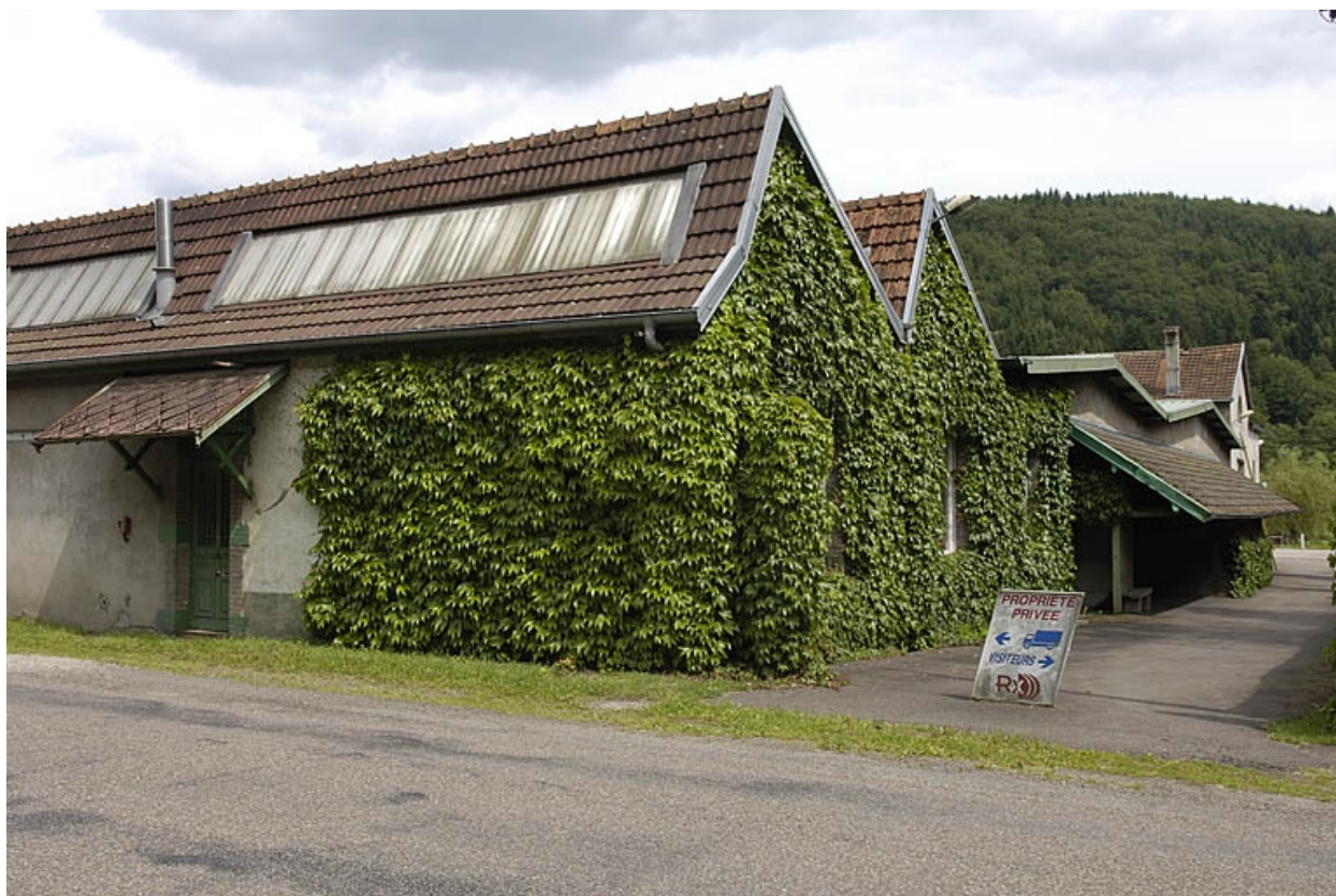
Ancienne entrée de l'usine.
