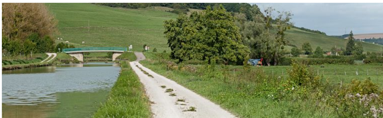
Vue du pont.
