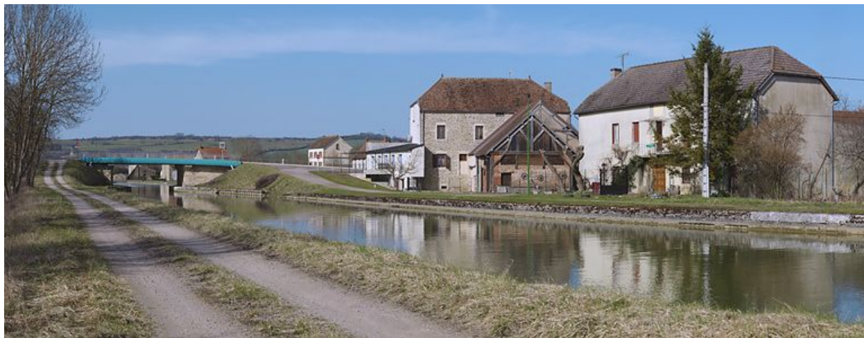
Arrivée en amont du pont : fermes sur la rive droite.
