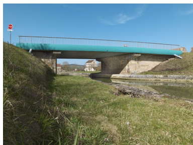
Le pont routier : on distingue la maison de perception en dessous. Phot. Thierry Kuntz IVR26_20122102718NUC4A
