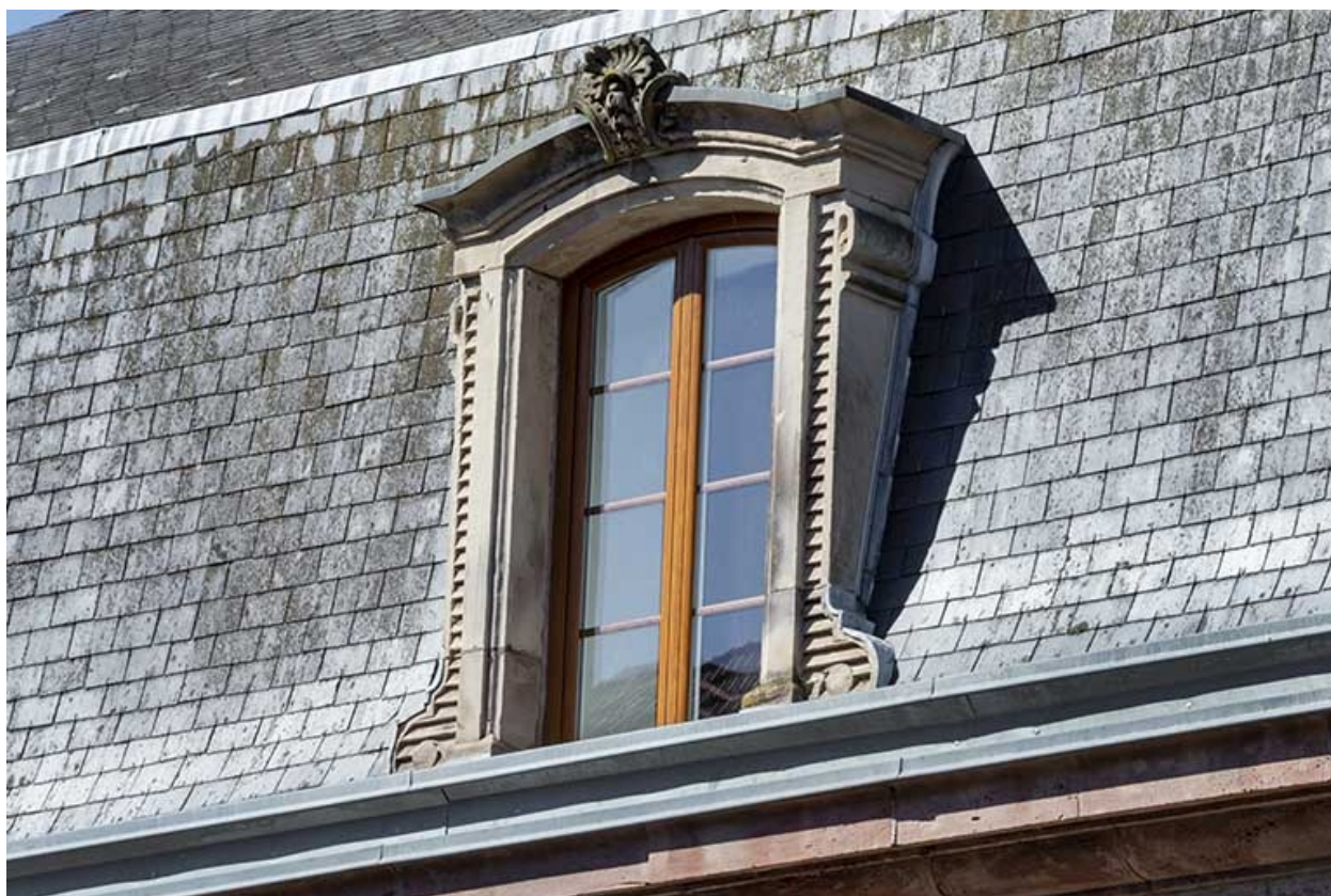
Maison Desgranges, lucarne est (lucarne centrale).
