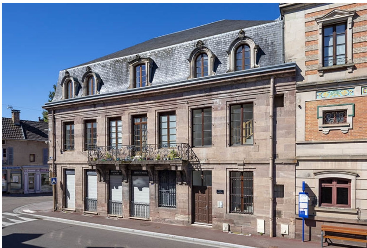
Maison Desgranges, façade est.
