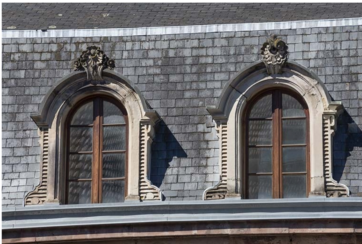
Maison Desgranges, lucarnes est (lucarnes latérales).
