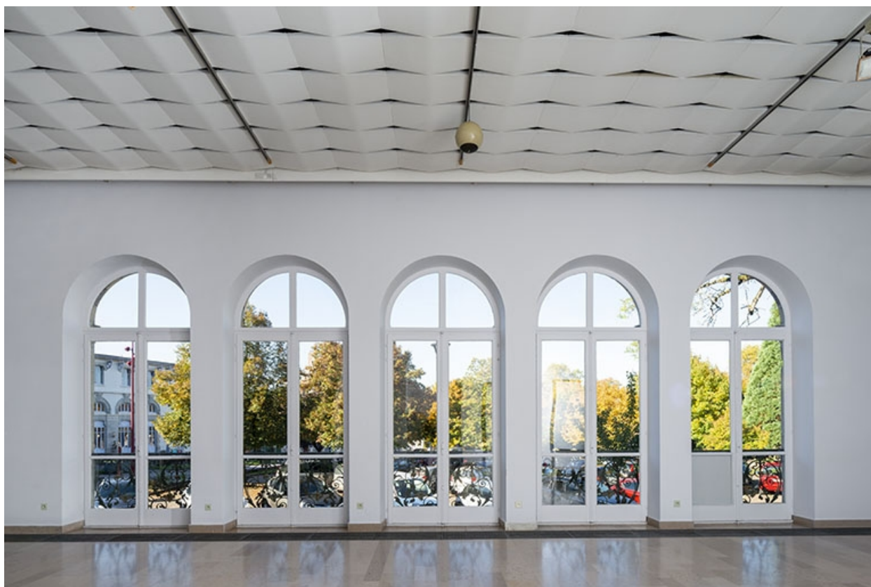
Galerie, vue en direction de l'ouest.
