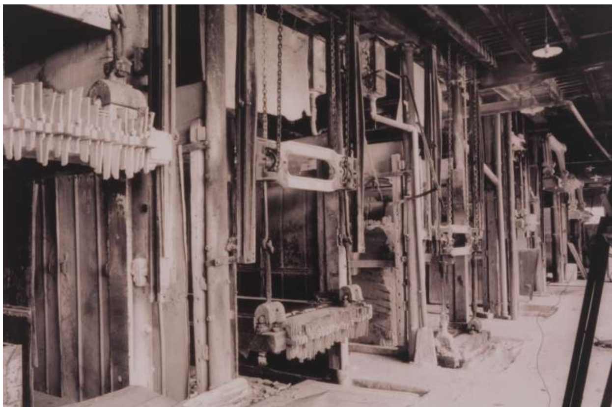
Vue d'ensemble des châssis multilames.
