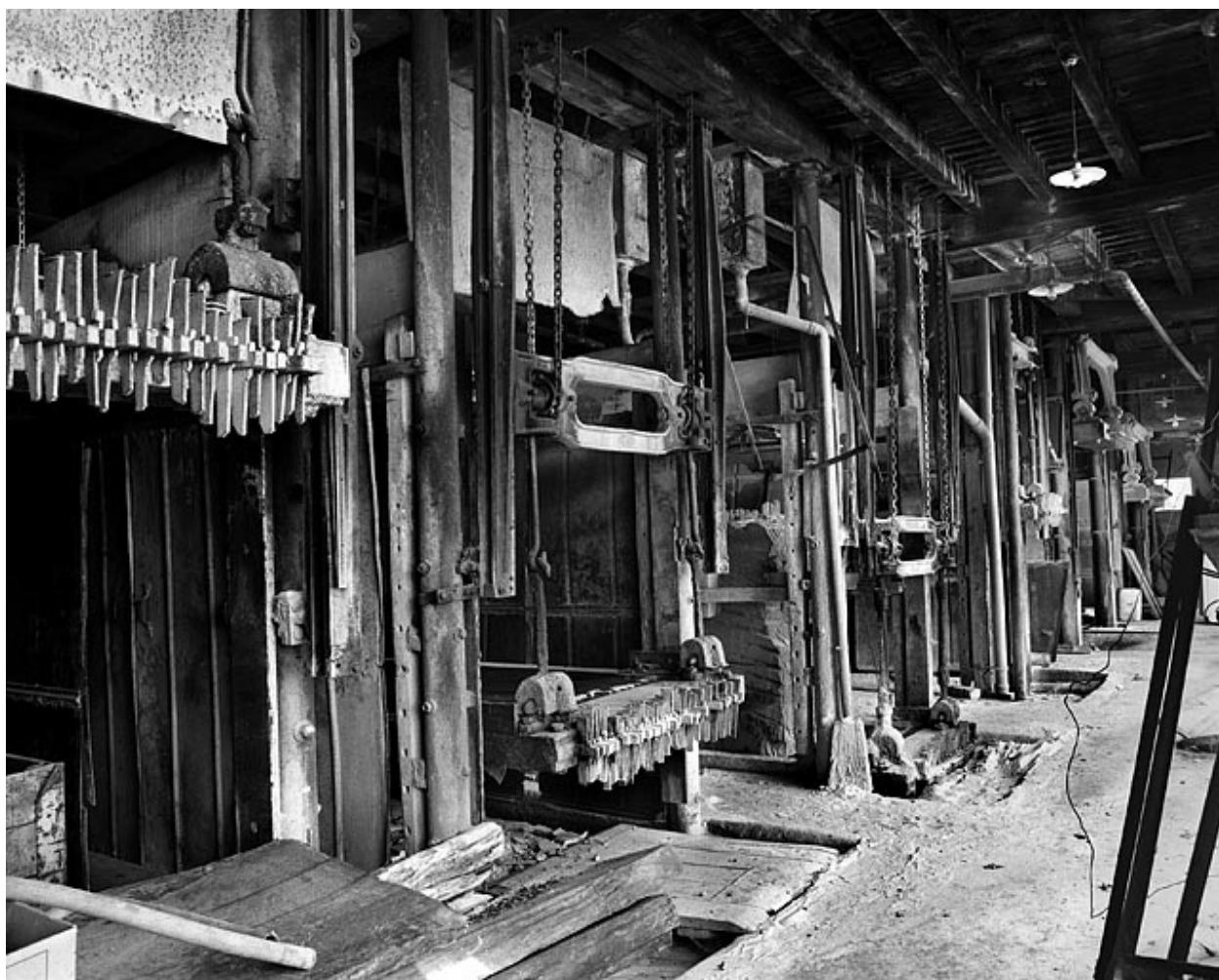
Vue d'ensemble des châssis multilames.
