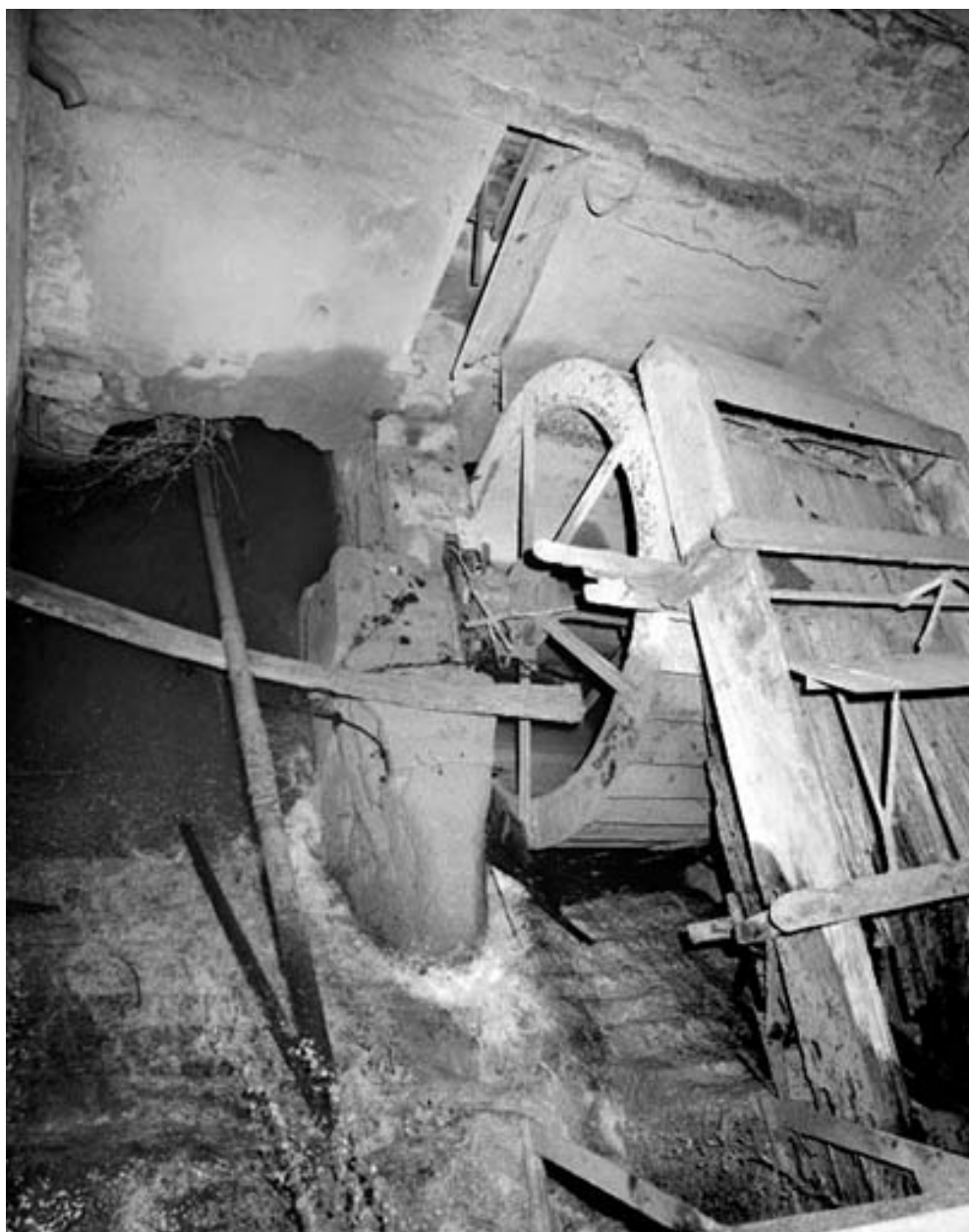
Roue hydraulique verticale.
