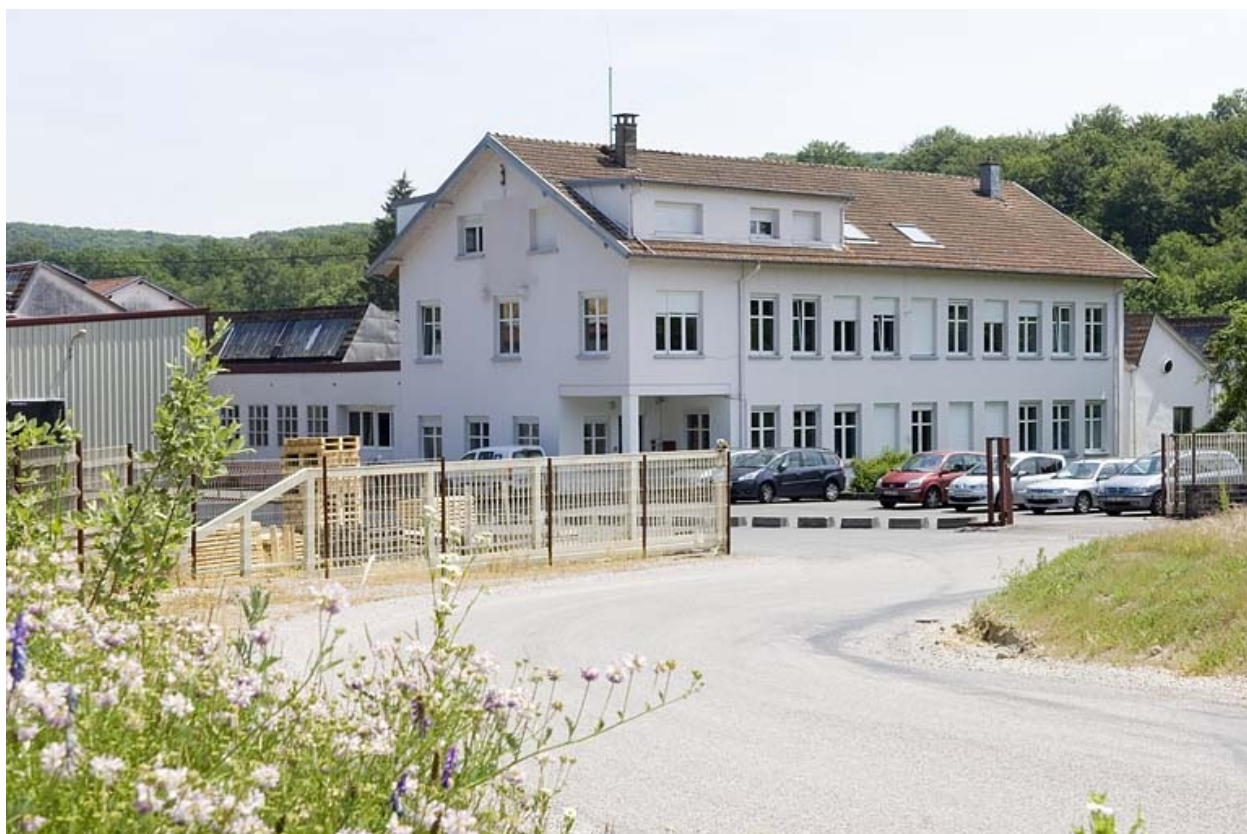
Le bâtiment des bureaux.
