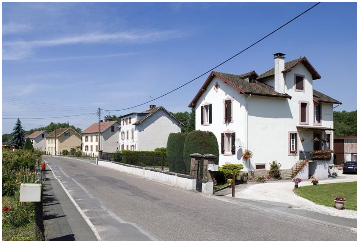
Maisons ouvrières rue de la Papeterie.
