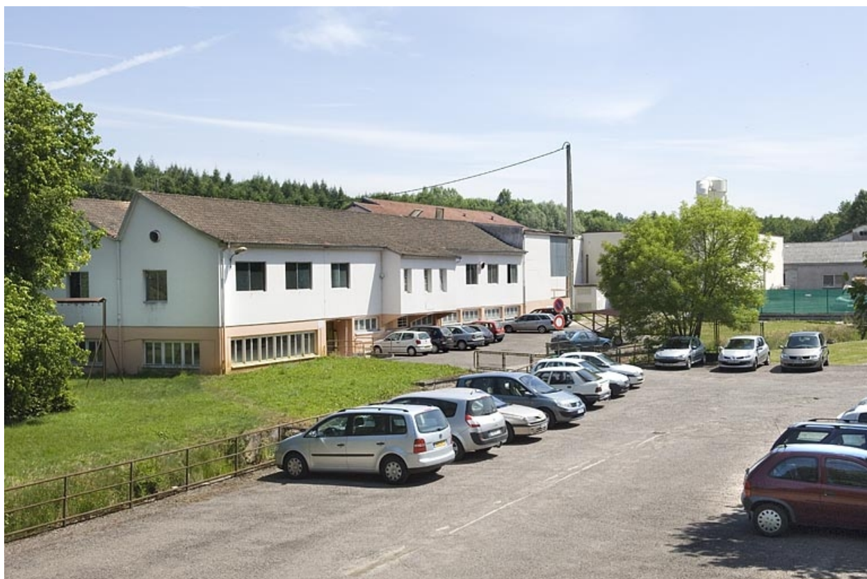
Vue depuis le sud-ouest.
