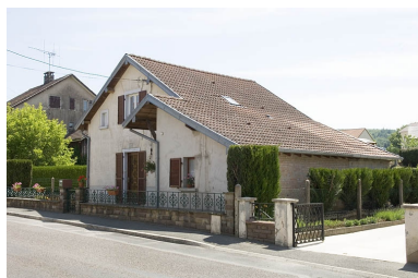
Maison individuelle. Phot. Jérôme Mongreville IVR43_20097000314NUC2A
