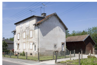
Logement ouvrier et son bûcher. Phot. Jérôme Mongreville IVR43_20097000313NUC2A
