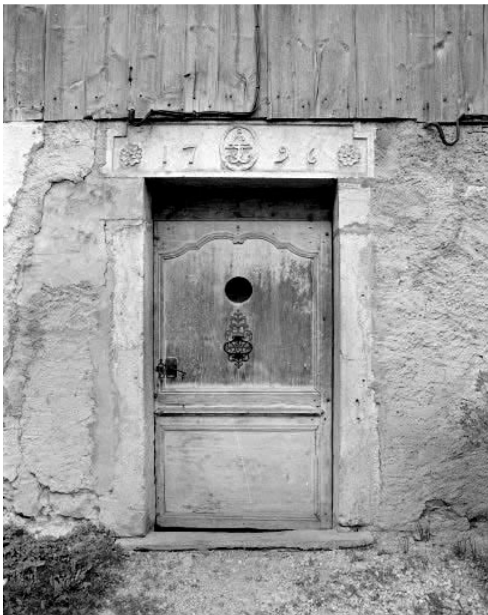
Façade antérieure : porte d'entrée.
