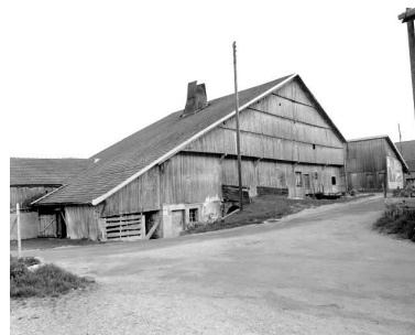
Façade antérieure. Phot. Dominique Humbert IVR43_19762500606X
