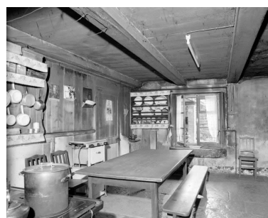
Intérieur : cuisine droite, vue depuis le "tué". Phot. Dominique Humbert IVR43_19762500609X
