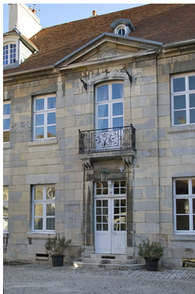
Façade antérieure : détail de la partie centrale.
