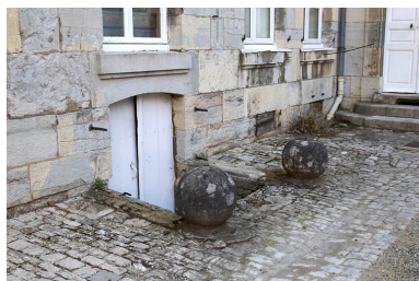
Cour : détail de l'entrée de cave. Phot. Yves Sancey IVR43_20122500327NUC2A
