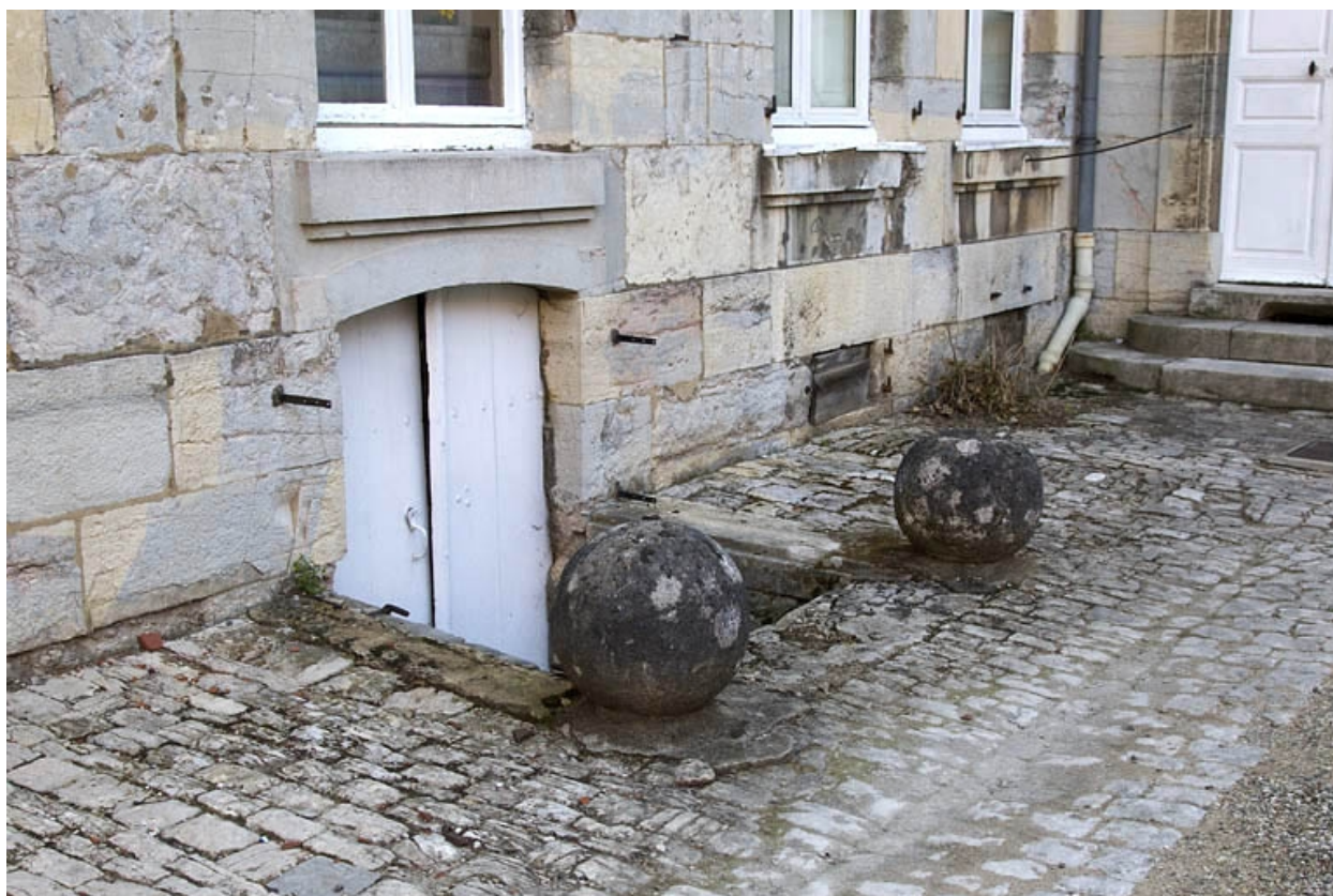
Cour : détail de l'entrée de cave.
