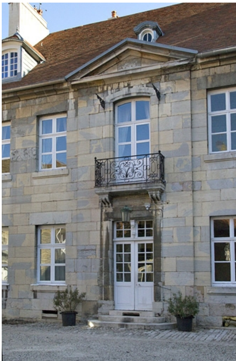
Façade antérieure : détail de la partie centrale.
