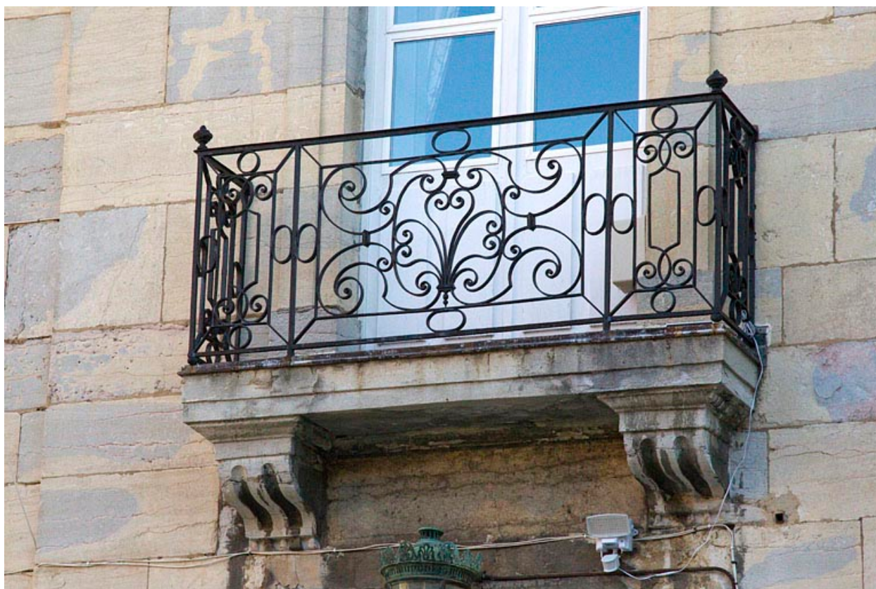
Façade antérieure, partie centrale : détail du balcon.
