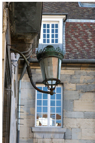
Façade antérieure : détail du bec de gaz.
