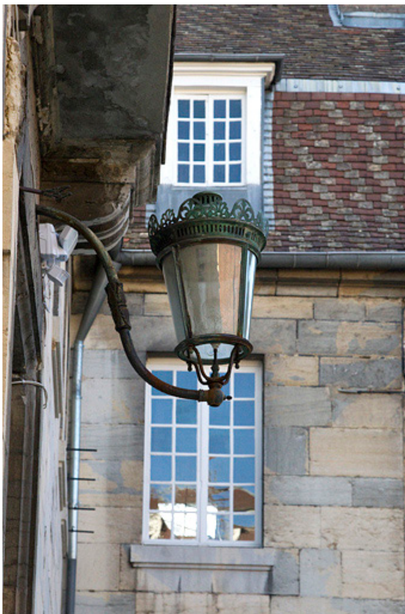
Façade antérieure : détail du bec de gaz.
