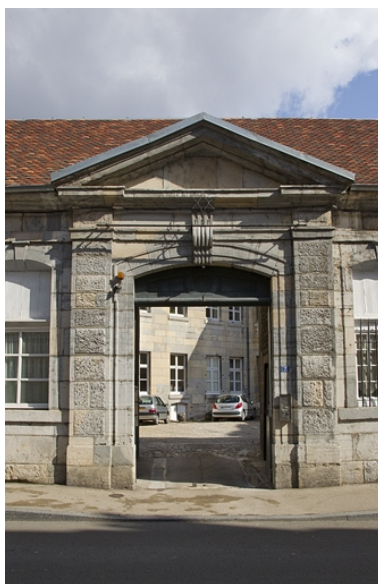
Vue du portail dans clôture : de face.
