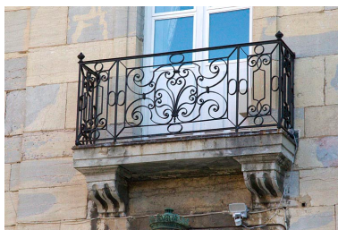
Façade antérieure, partie centrale : détail du balcon.
