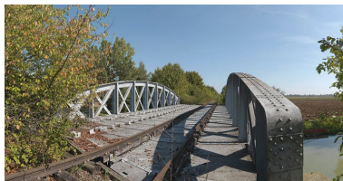
Détail du platelage : la voie fermée restante est bien visible. Phot. Thierry Kuntz IVR26_20112103406NUC4A
