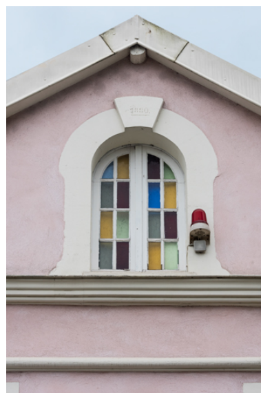
Logement : baie du comble. Phot. Pierre-Marie Barbe-Richaud IVR26_20238900422NUC4A
