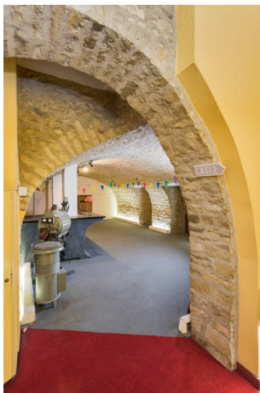
Cave voûtée servant de foyer. Phot. Pierre-Marie Barbe-Richaud IVR26_20238900438NUC4A
