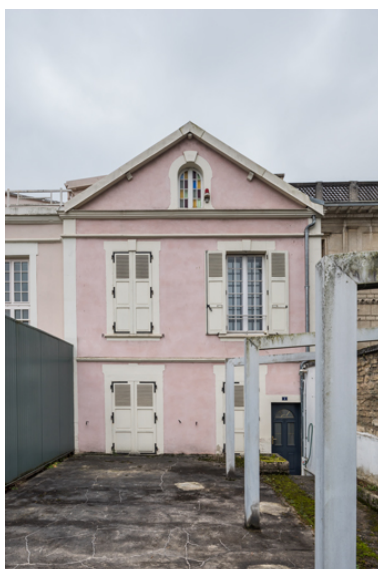
Façade du logement. Phot. Pierre-Marie Barbe-Richaud IVR26_20238900421NUC4A
