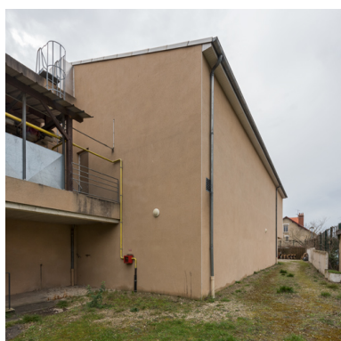
Salle 8, vue du nord. Phot. Pierre-Marie Barbe-Richaud IVR26_20238900432NUC2A
