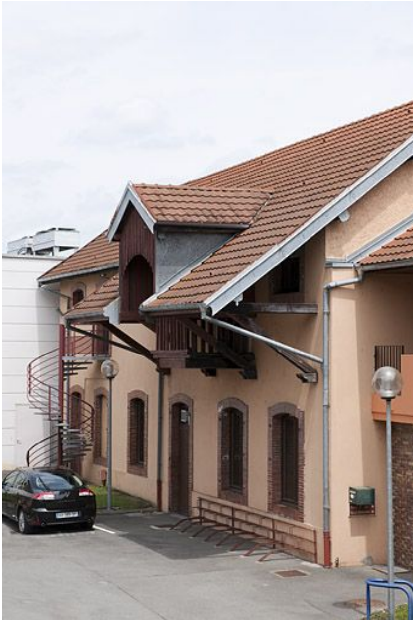
Façade des magasins de stockage.
