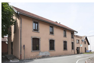
Ancien magasin de boucherie. Phot. Jérôme Mongreville IVR43_20112501609NUC4A
