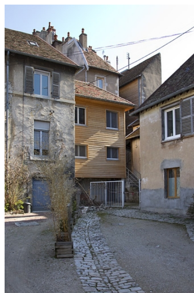
Vue de l'entrée de la première cour. Phot. Yves Sancey IVR43_20122500654NUC2A
