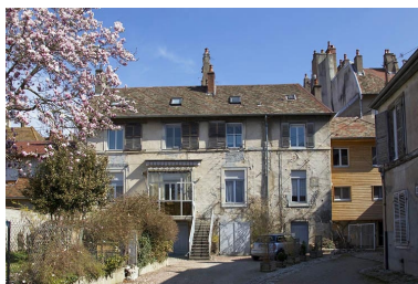
Vue du premier logis secondaire, de face. Phot. Yves Sancey IVR43_20122500653NUC2A
