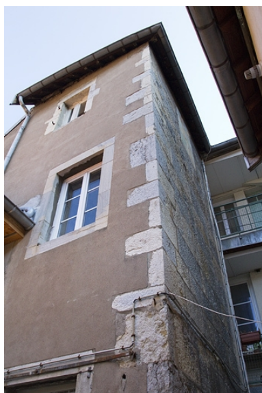
Logis principal : détail de l'aile sur cour. Phot. Yves Sancey IVR43_20122500648NUC2A
