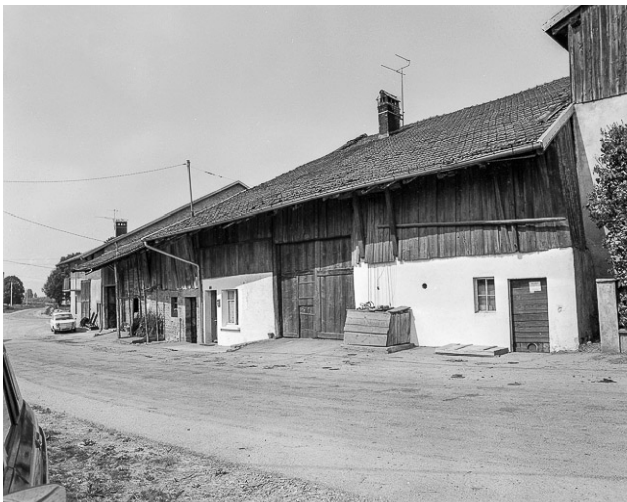
Ferme située rue de l'Ecole : façade antérieure.
