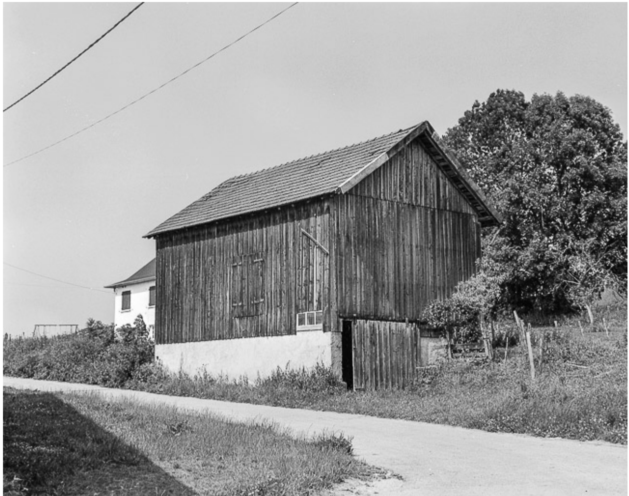
Remise cadastrée 1933 B1 94 : vue d'ensemble.
