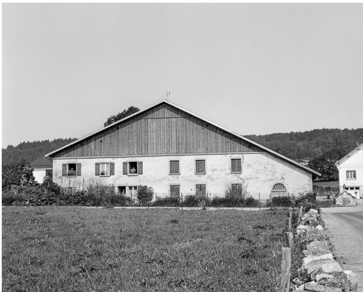
Ferme située rue de l'Ecole : façade antérieure.
