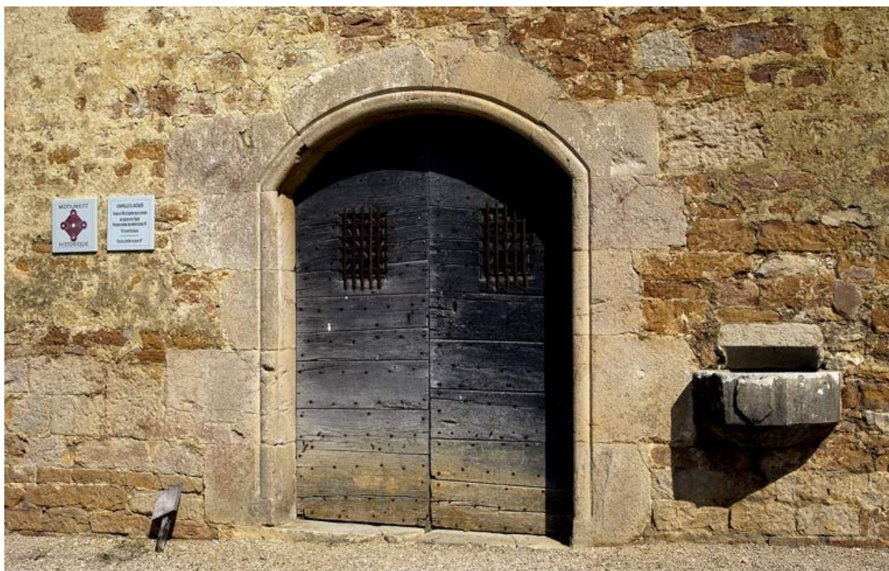
Détail du portail d'entrée et du bénitier.
