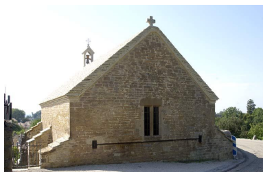
Façade postérieure. Phot. Michel Thierry IVR26_20047101175NUC2A
