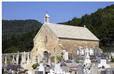
Façade antérieure et façade droite. Phot. Michel Thierry IVR26_20047101174NUC2A
