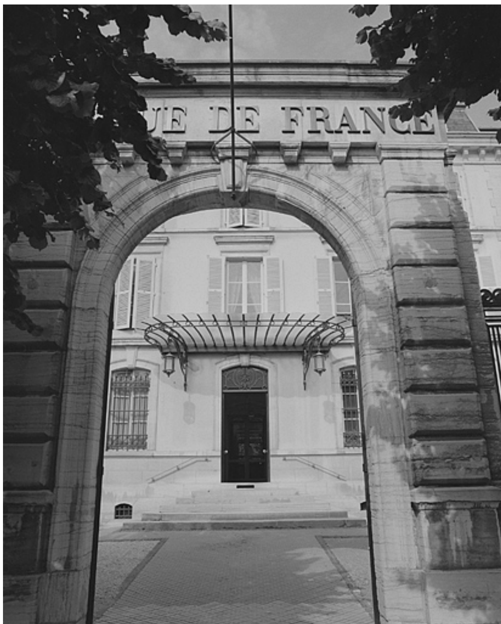
Portail d'accès à la cour.
