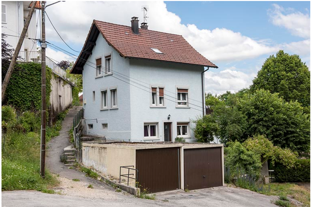
Maison : façades postérieure et latérale droite.
