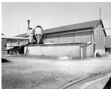
Atelier de fabrication, atelier de conditionnement, bureau. Phot. Jérôme Mongreville IVR43_19963900447X
