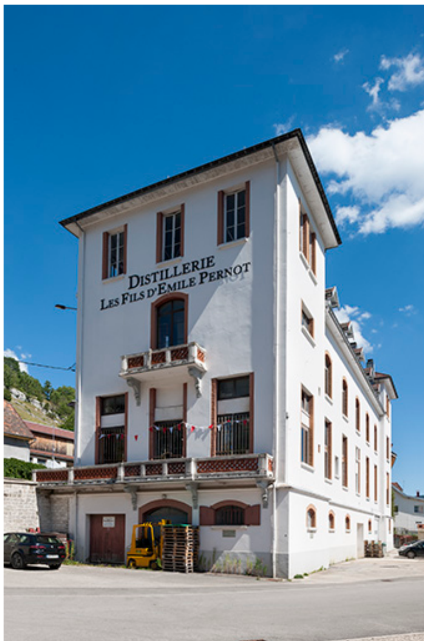
Pignon ouest et façade postérieure.
