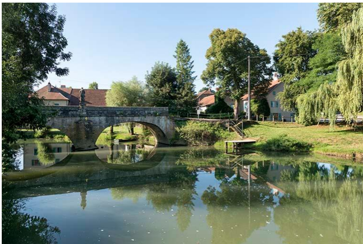
Vue du pont côté Nord
