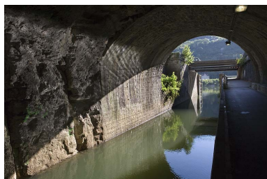
Vue d'ensemble depuis le tunnel. Phot. Yves Sancey IVR43_20062500146NUCA
