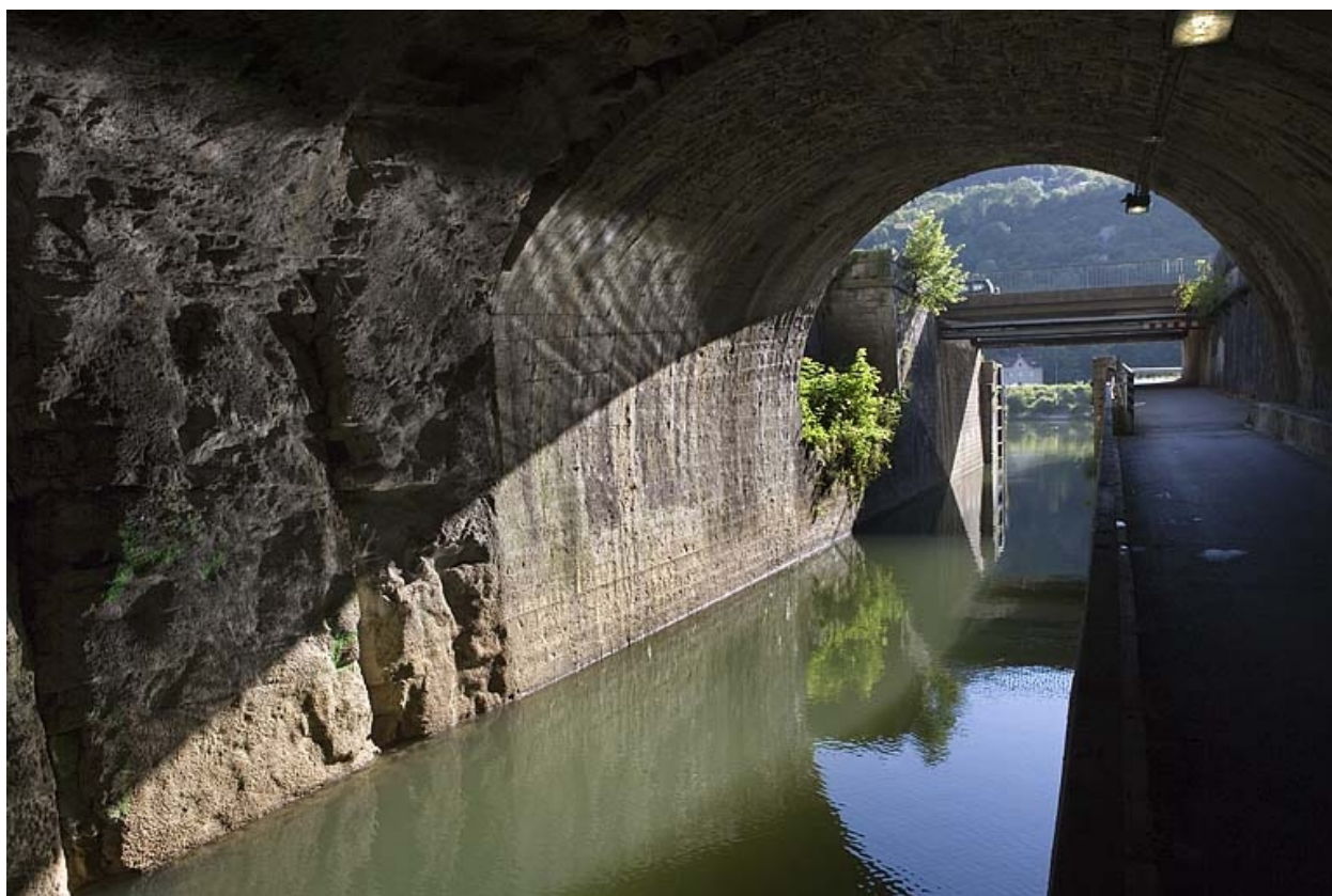
Vue d'ensemble depuis le tunnel.
