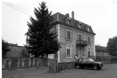
Vue d'ensemble. Phot. Bernard Lardière IVR43_19832500140Z
