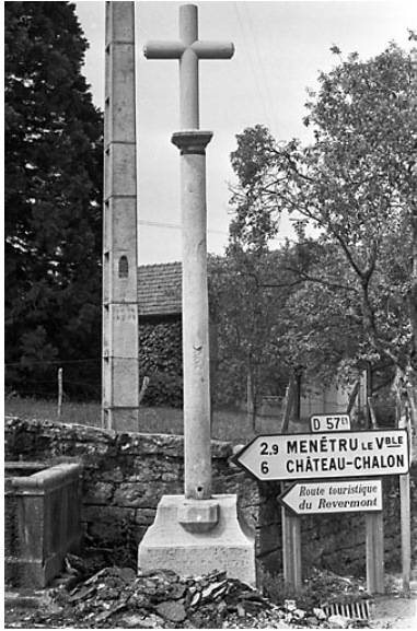
Vue générale. Phot. Guy Forestier IVR43_19743900291Z
