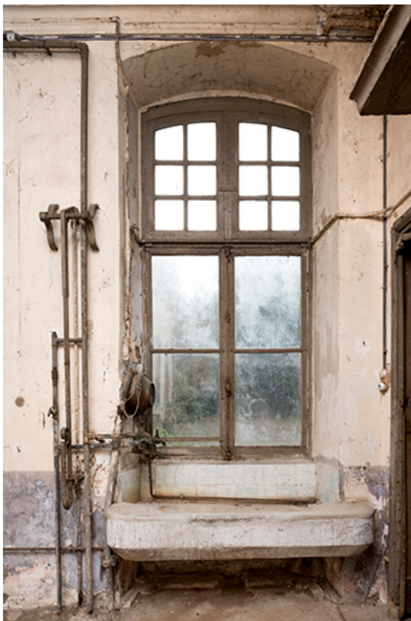
Rez de chaussée, cuisine, pierre d'évier.
