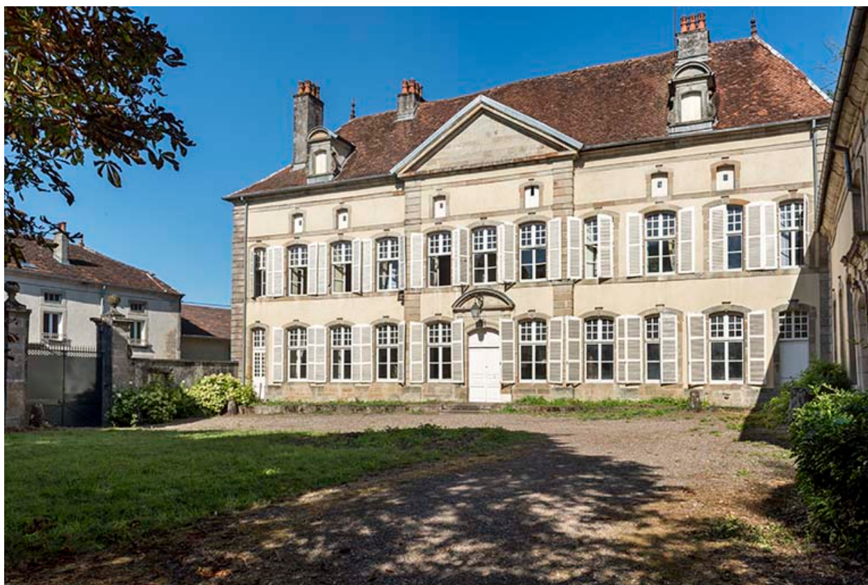
Façade principale vue de l'est.
