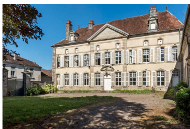
Façade principale vue de l'est. Phot. Sonia Dourlot IVR43_20167001149NUC4A
