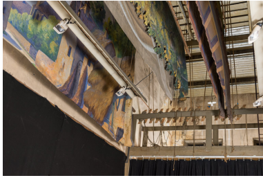
Scène : passerelle avec palettes et fils de commande, décor de fond et frises. Phot. Pierre-Marie Barbe-Richaud IVR26_20257100518NUC4A
