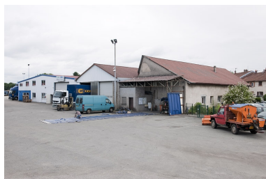
Vestiges d'un bâtiment industriel (à droite). Phot. Jérôme Mongreville IVR43_20122501133NUC4A
