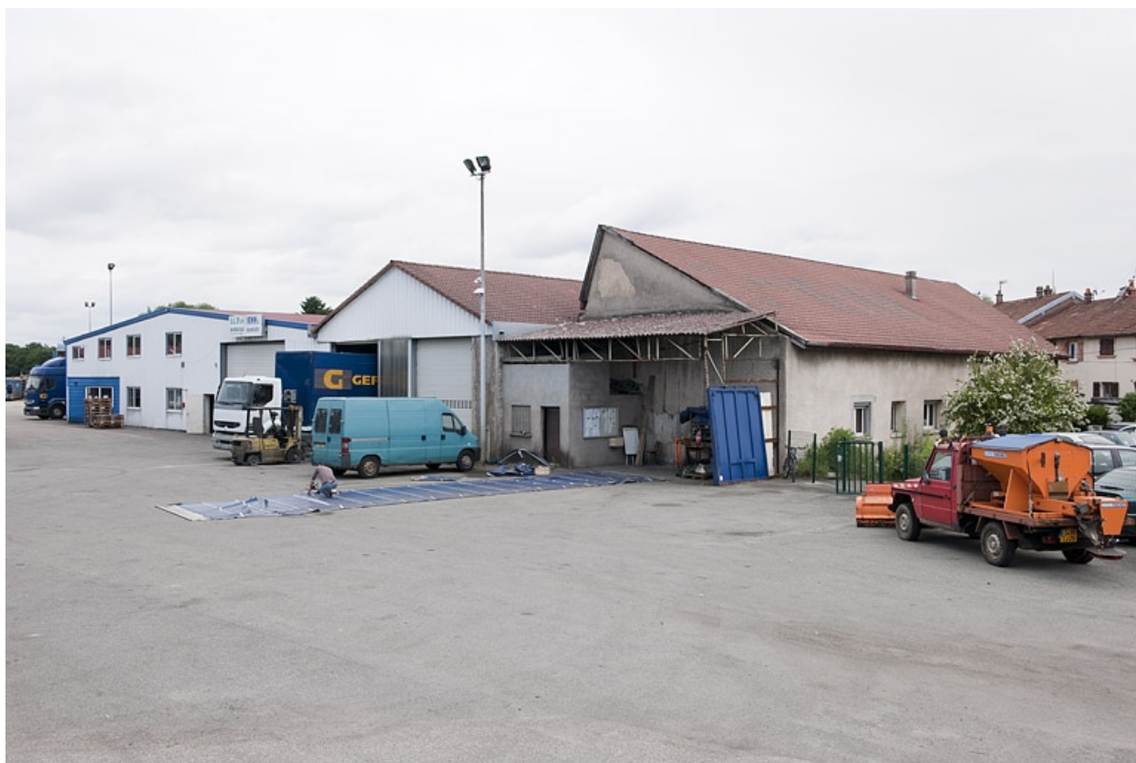
Vestiges d'un bâtiment industriel (à droite).
