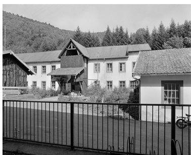
Atelier de fabrication (préparation, bobinage, ourdissage, etc).
