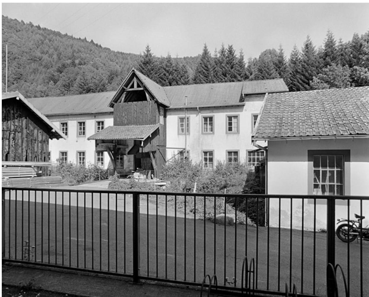
Atelier de fabrication (préparation, bobinage, ourdissage, etc).
