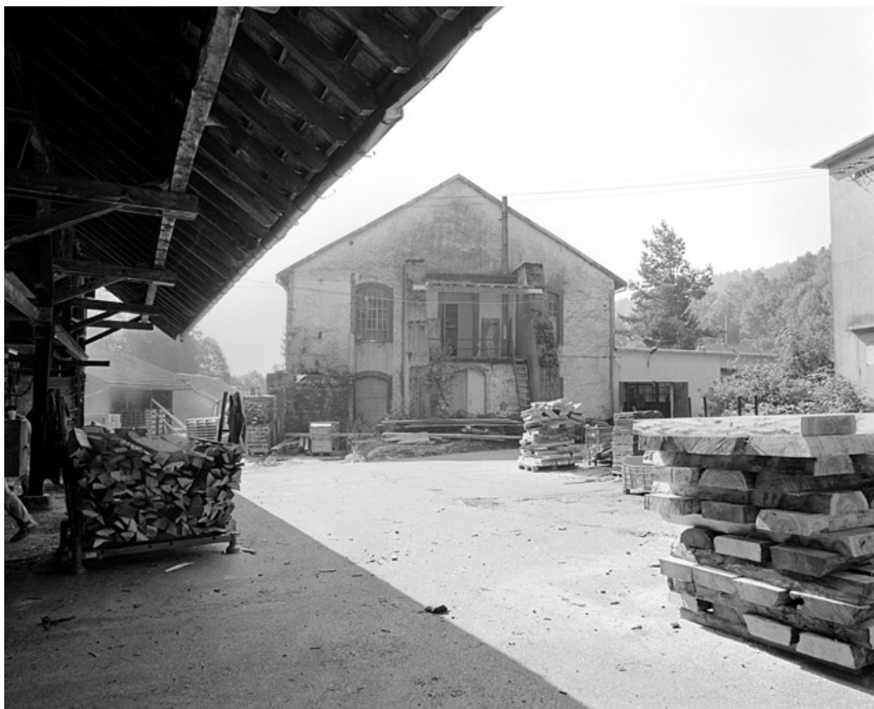
Pignon nord de la salle de tissage.
