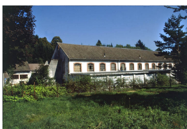
Façade occidentale de la salle de tissage.
