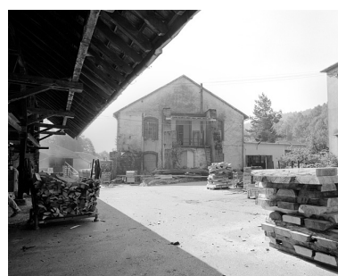
Pignon nord de la salle de tissage.
