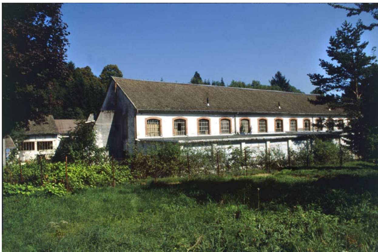
Façade occidentale de la salle de tissage.
