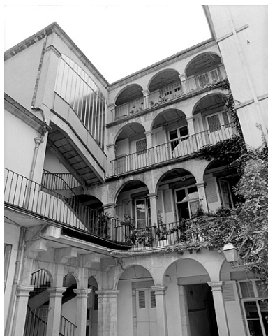
Façade postérieure et escalier. Phot. Yves Sancey IVR43_19883900278X
