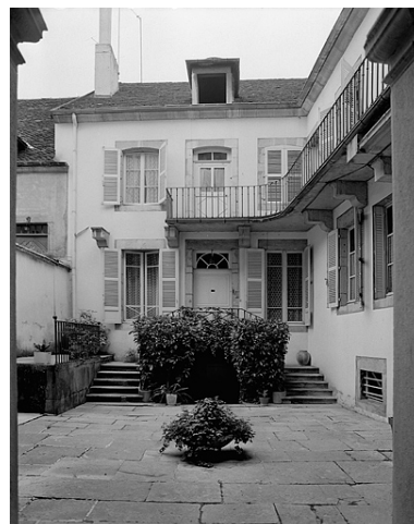
Maison particulière en fond de cour. Phot. Yves Sancey IVR43_19883900281X
