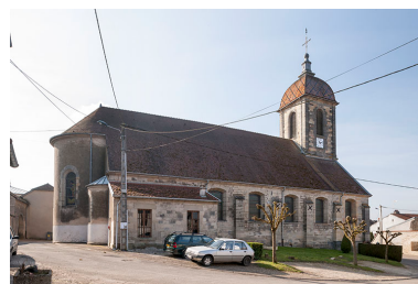
Vue de la façade nord. Phot. Jérôme Mongreville IVR43_20167000424NUC4A
