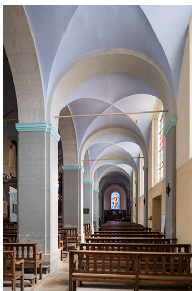
Collatéral de la nef. Phot. Jérôme Mongreville IVR43_20167000412NUC4A
