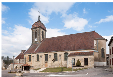
Vue de la façade sud. Phot. Jérôme Mongreville IVR43_20167000407NUC4A
