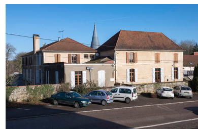
Vue générale depuis l'église. Phot. Jérôme Mongreville IVR43_20177000098NUC4A
