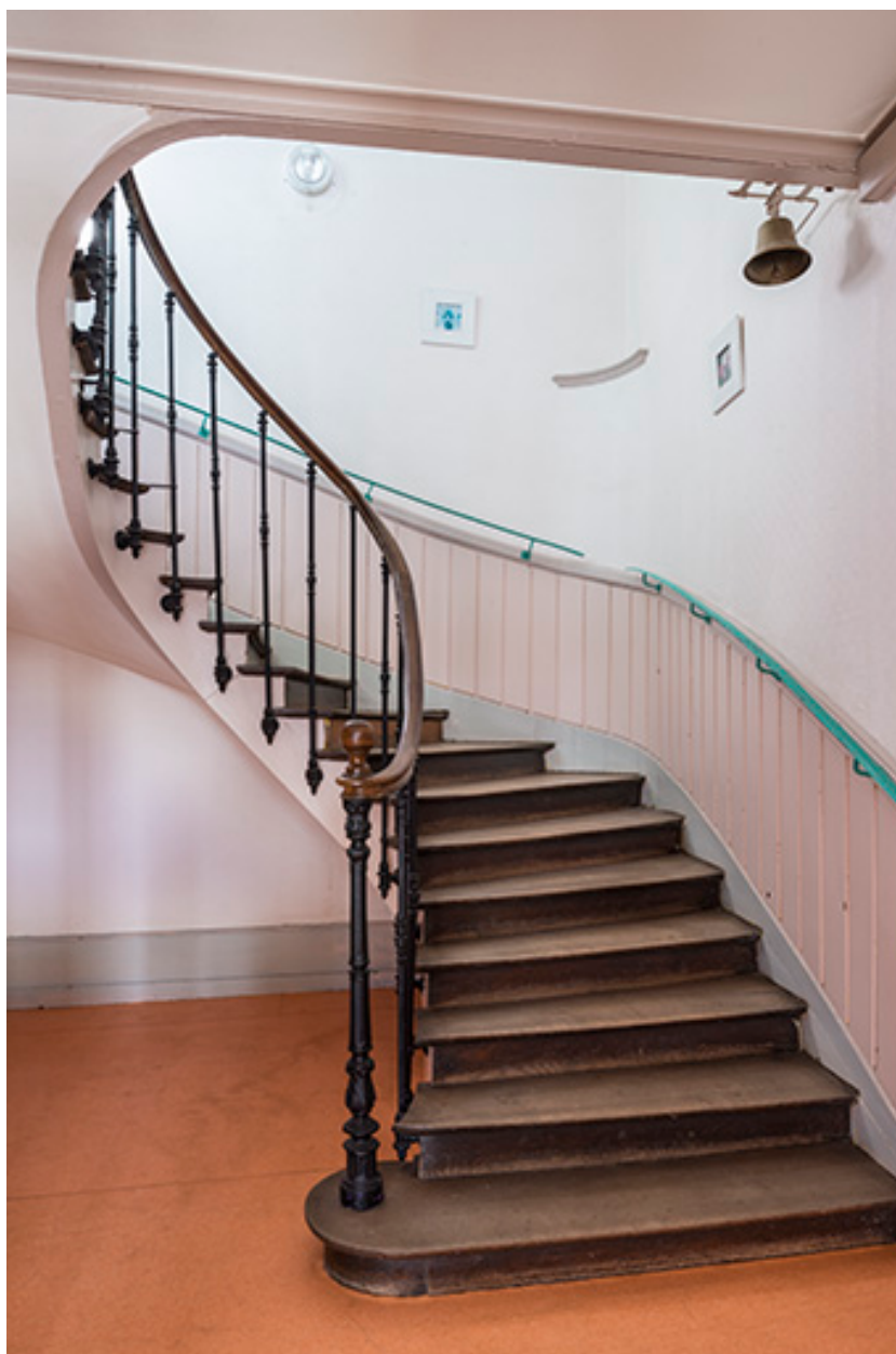
Escalier d'accès au premier étage.
