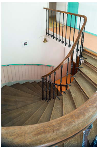
Détail depuis le premier étage. Phot. Jérôme Mongreville IVR43_20177000103NUC4A
