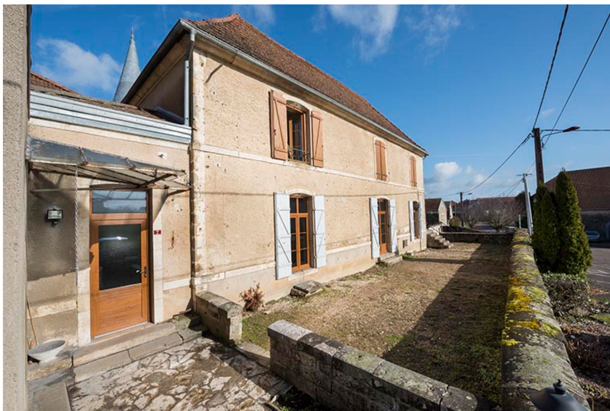
Détail de la façade sud.
