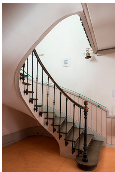
Escalier de type suspendu. Phot. Jérôme Mongreville IVR43_20177000102NUC4A
